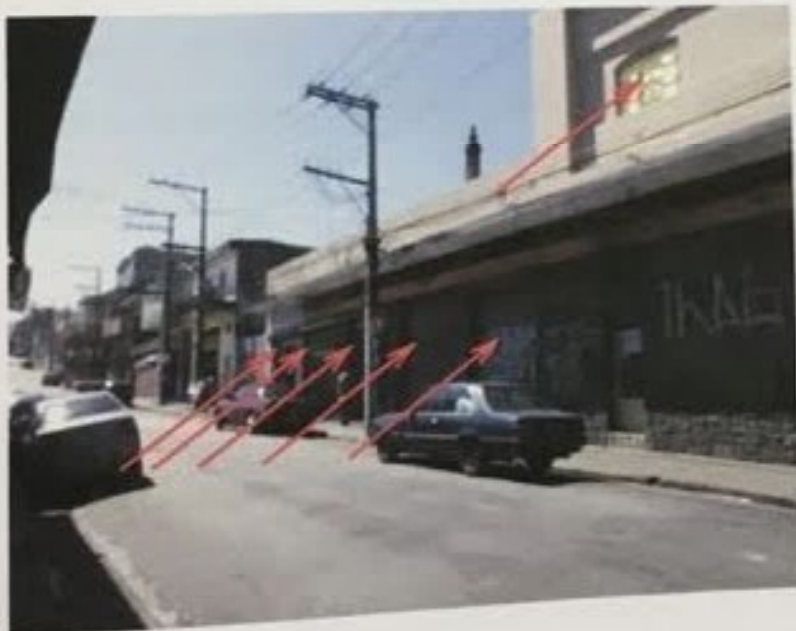
Fotos 7/8 - Vistas da fachada do imóvel avaliando enfocada da rua Coronel Rodrigues. Destaque para as unidades comerciais no pavimento térreo e as residenciais no pavimento superior (apontadas).
