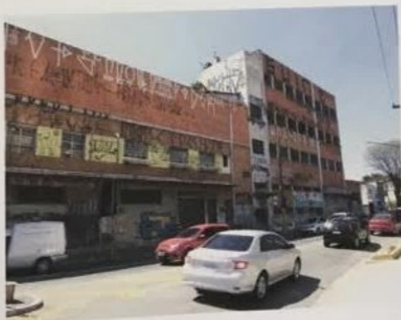
Fotos 3/4 - Vistas da fachada do imóvel avaliando enfocada da avenida Vila Ema, notando-se os detalhes cerâmicos na fachada.
