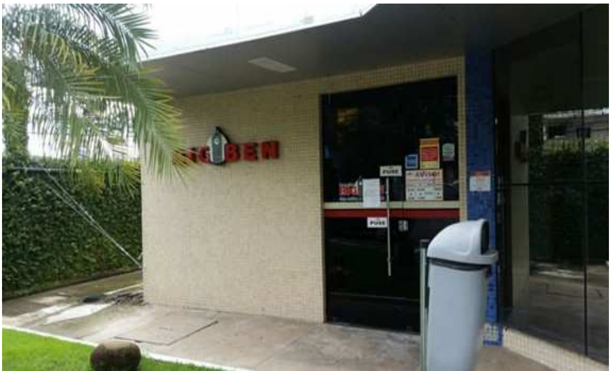
Vista do Ponto Comercial do Imóvel XXXII, localizado na Avenida Almirante Barroso, nº 1758, Bairro Marco, Belém, Pará.
