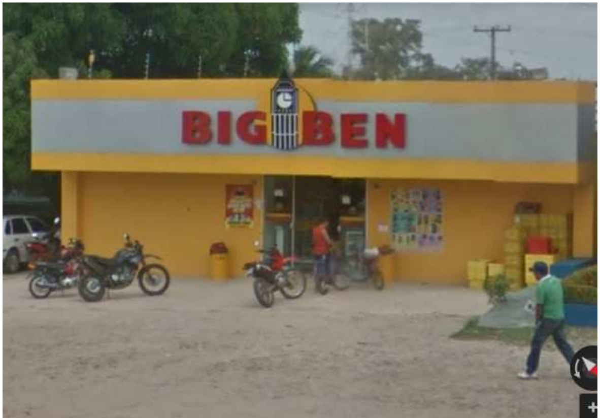
Vista do Ponto Comercial do Imóvel II, localizado na Avenida Tancredo Neves, nº 1283, Bairro Centro, São Miguel do Guamá, Pará.
