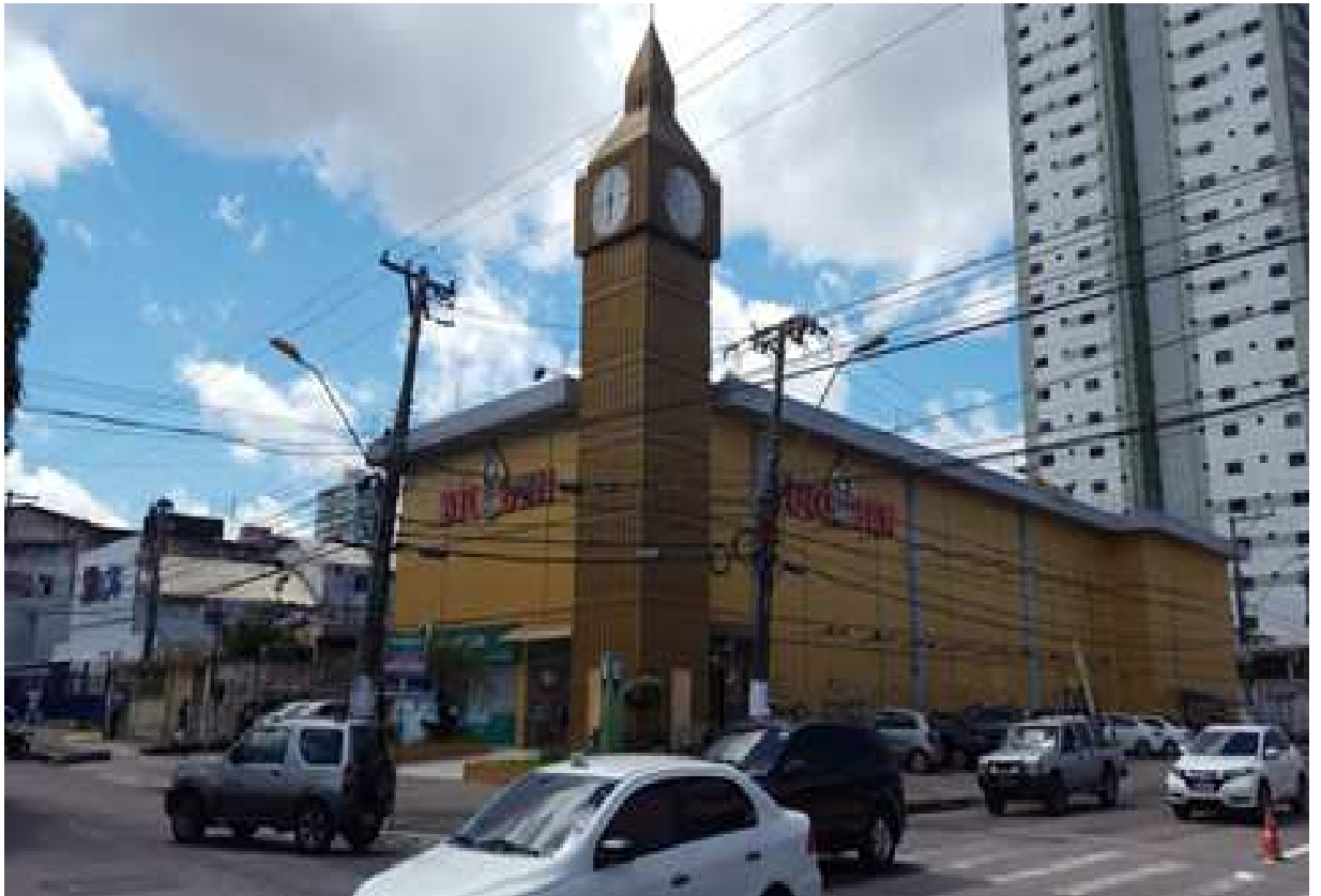
Vista do Ponto Comercial do Imóvel LXIX, localizado na Avenida Pedro Miranda, nº 712, Bairro Pedreira, Belém, Pará.
