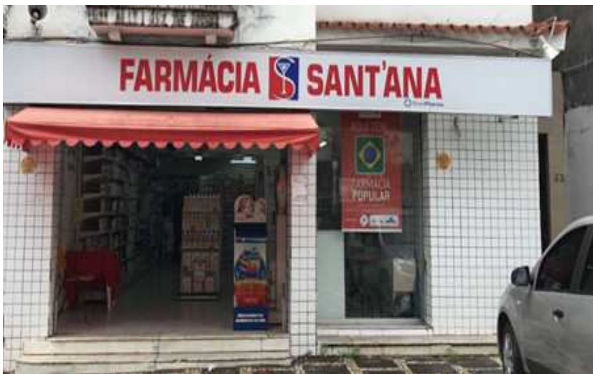
Vista do Ponto Comercial do Imóvel LVIII, localizado na Avenida Euclides da Cunha, nº 83, Bairro Graça, Salvador, Bahia.
