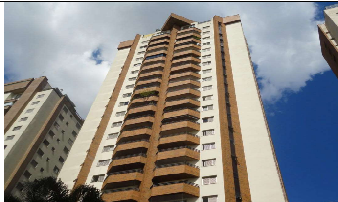
Vista externa da cobertura a direita
