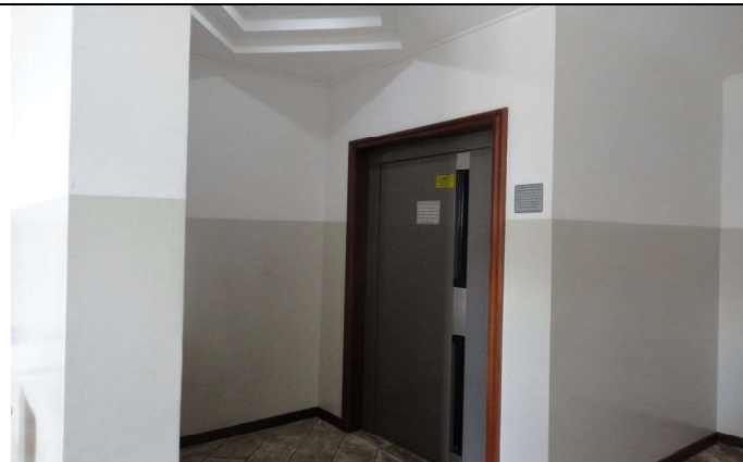
Um dos Elevadores do Condomínio
