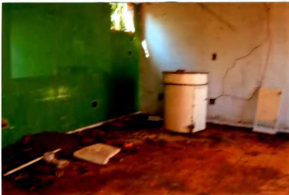
Vista parcial das condições do prédio destinado a administração e loja de conveniência do posto
