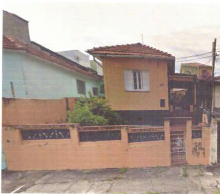
Fachada do Imóvel Avaliando
