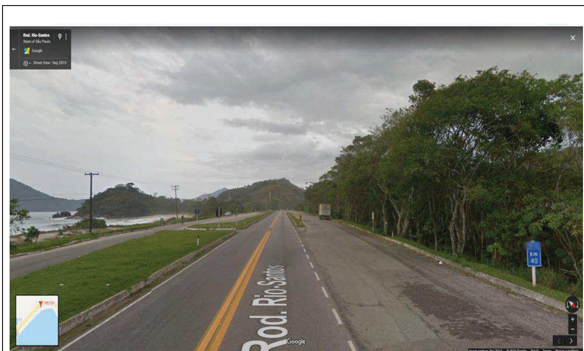
FOTO 01 – Vista geral do imóvel
