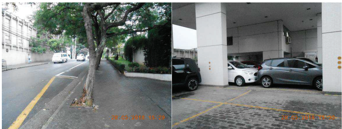
Fotos 07/08 - Vista parcial das vagas de garagem e vista parcial da via pública onde se situa a sala sub-judice .
