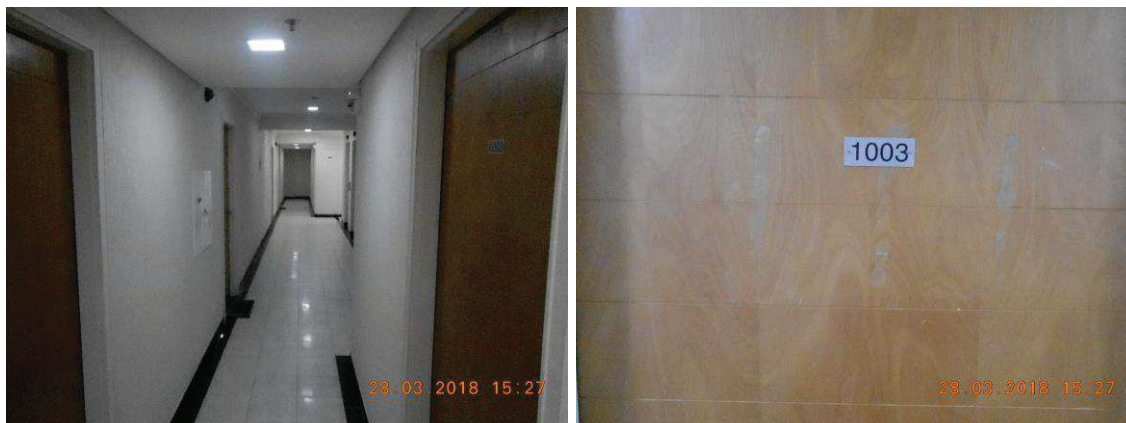
Fotos 05/06 - Vistas parciais do hall de acesso e da porta de entrada da sala sub-judice .
