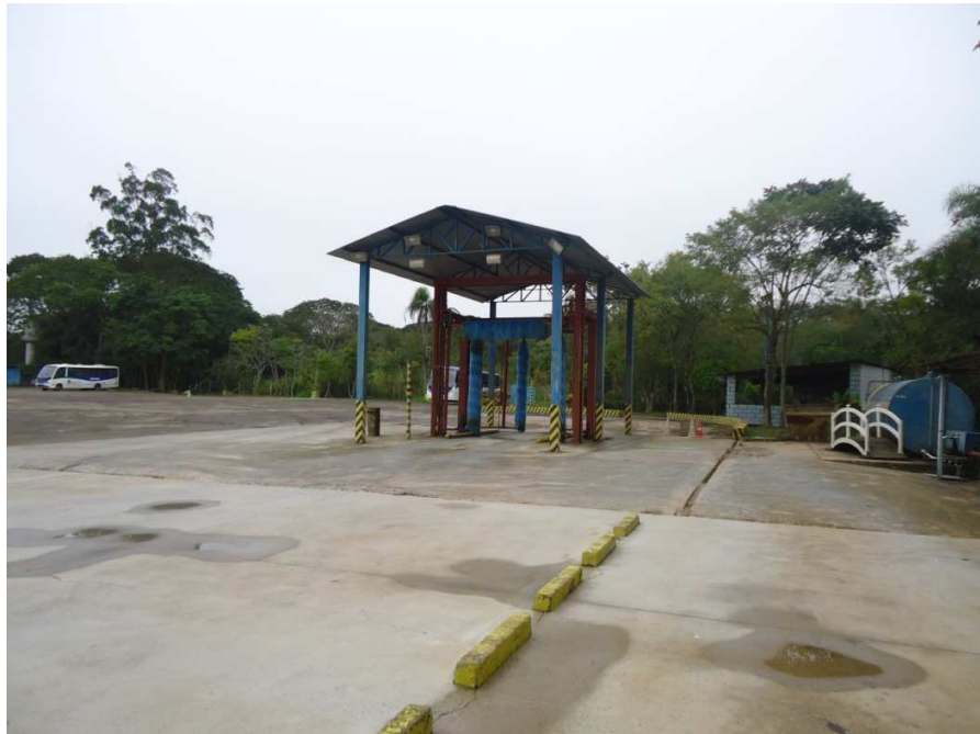
VISTA DA ÁREA DE LAVAGEM.
