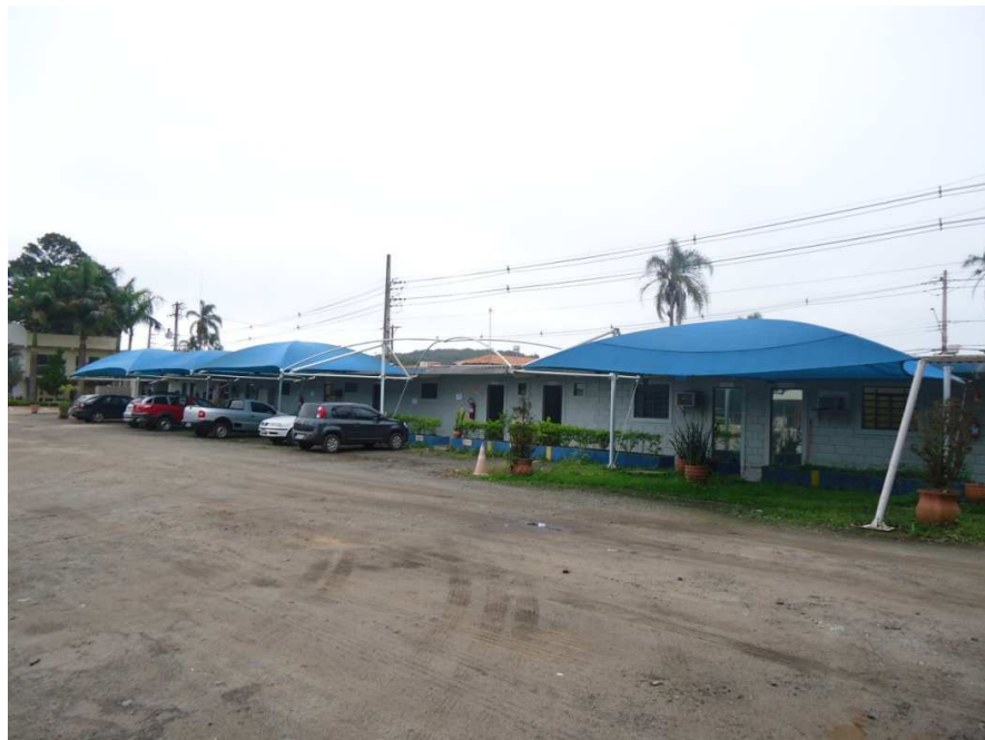
VISTA DA ÁREA OPERACIONAL.
