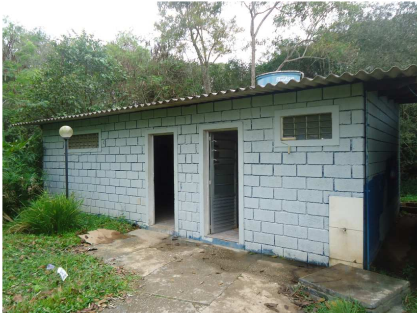
VISTA DO BANHEIRO PARA FUNCIONÁRIOS.
