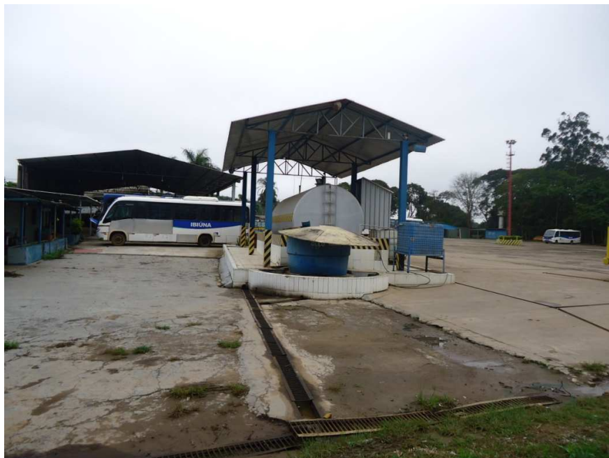
VISTA DAS BOMBAS DE COMBUSTÍVEL.
