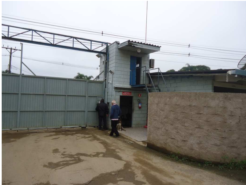
VISTA DA PORTARIA.
