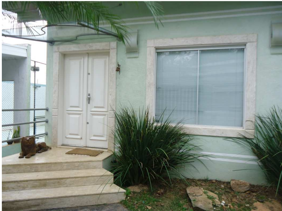
VISTA DA ÁREA EXTERNA.
