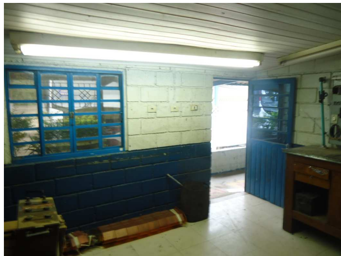
VISTA DA ÁREA DE CIRCULAÇÃO INTERNA.
