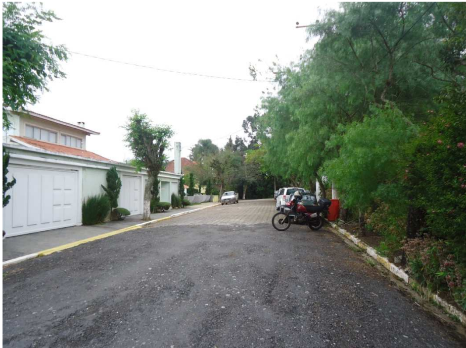
VISTA, NO SENTIDO CONTRÁRIO DE DIREÇÃO, DA VIA.
