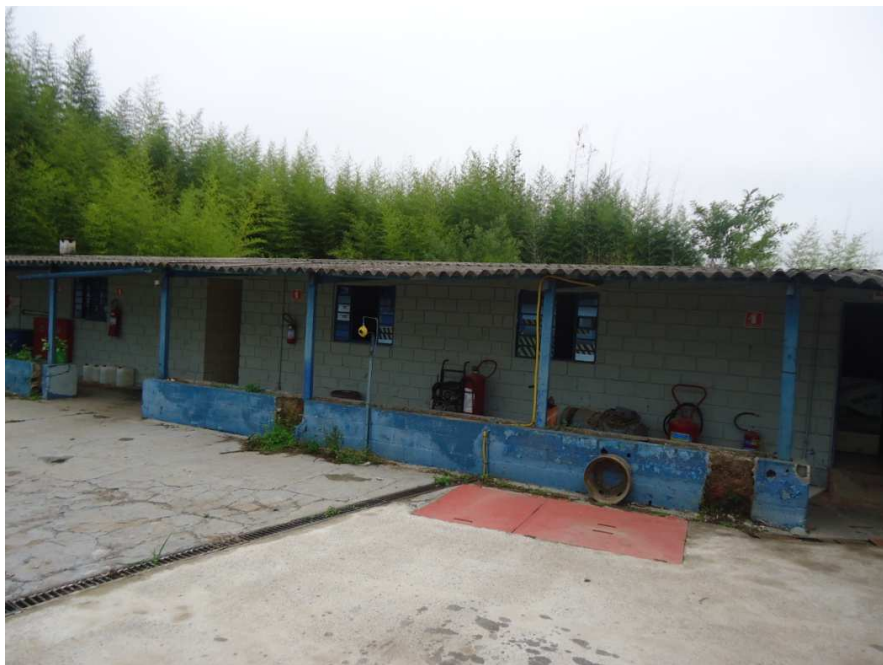
VISTA DA ÁREA AUXILIAR DE SERVIÇO.
