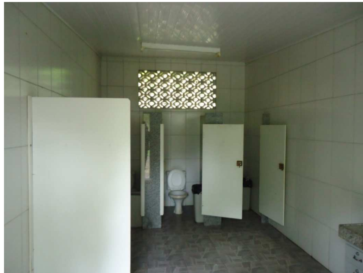
VISTA DA ÁREA DE CIRCULAÇÃO INTERNA.
