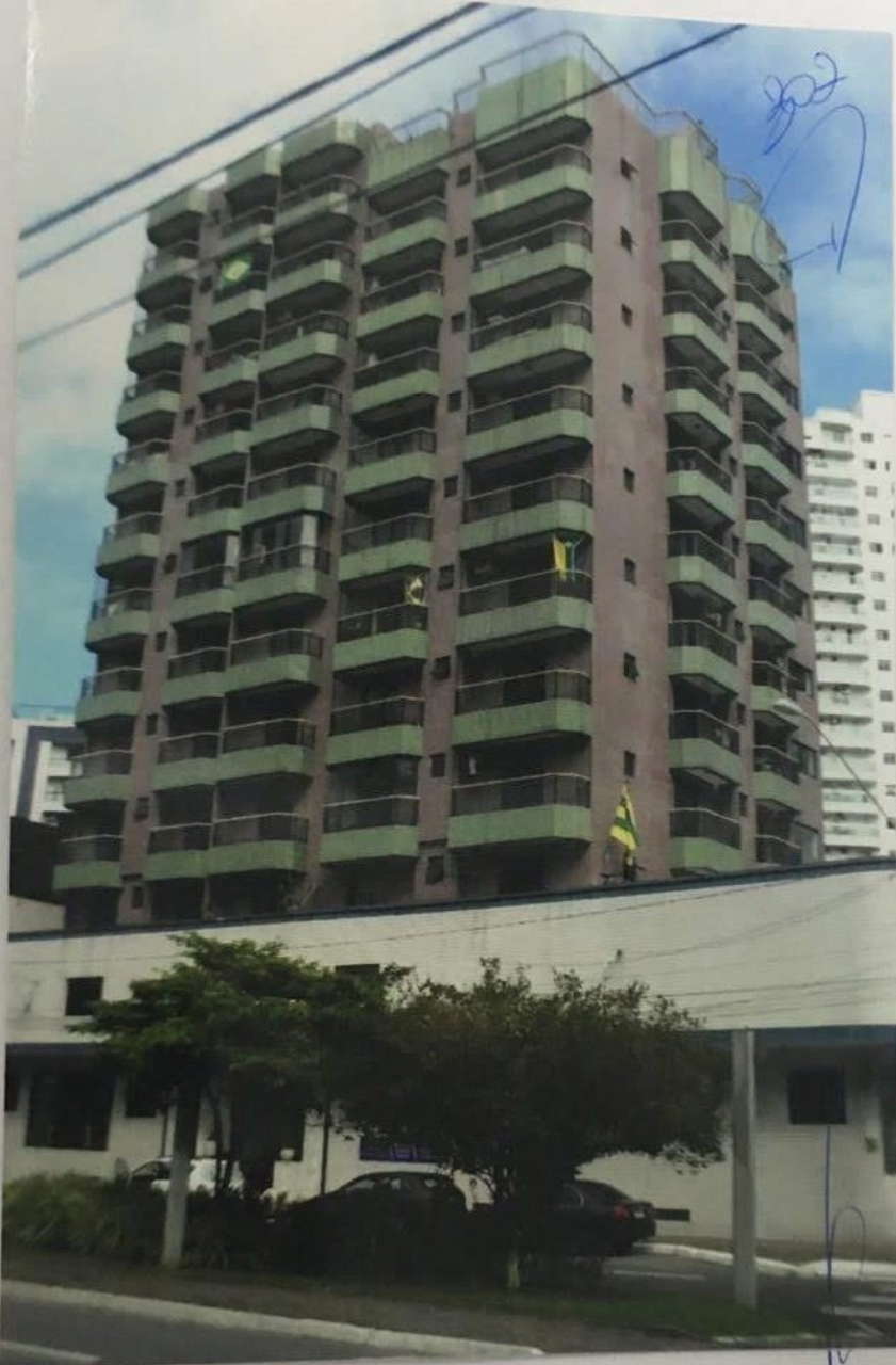
Foto nº 01 – fachada do Condomínio Bloco "A" do Condomínio Residencial Forte , do apartamento nº 101 avaliando, frente para Av. Marechal Mallet
