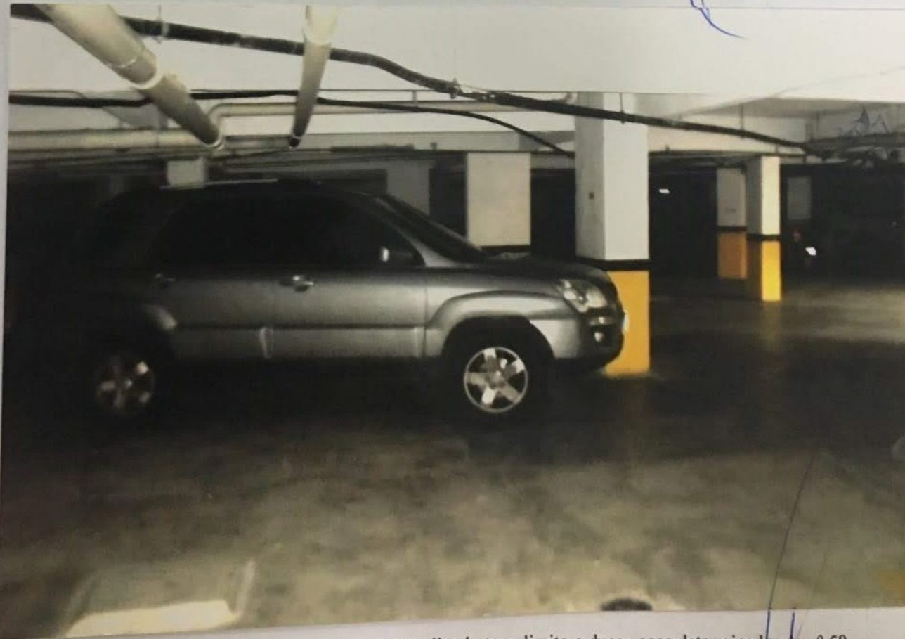
Foto nº 3 - Detalhe da garagem coletiva no piso térreo onde o apartamento avaliando tem direito a duas vagas determinadas de nº 58 e de nº 59.
