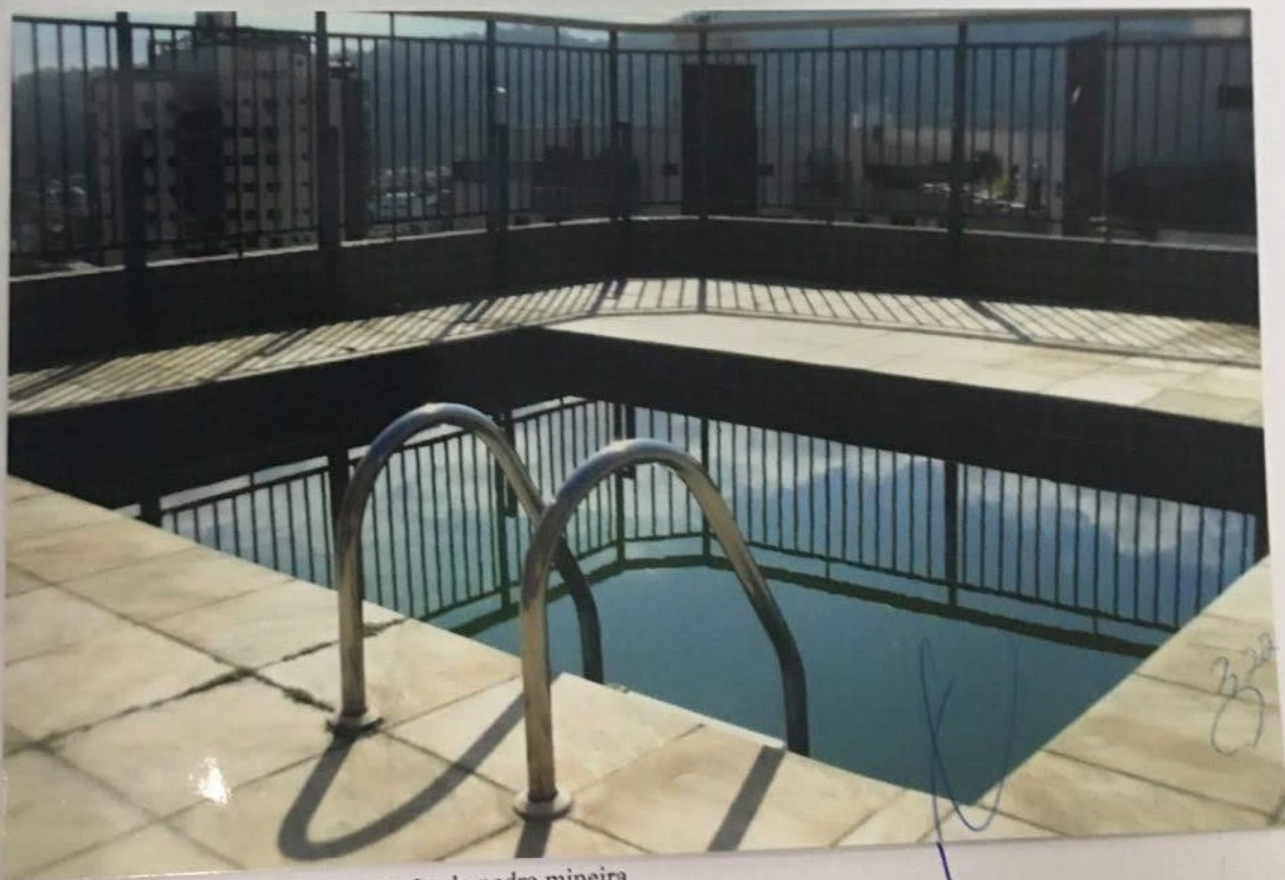
foto nº 21 -piscina com revestimento cerâmico e pavimentação de pedra mineira
