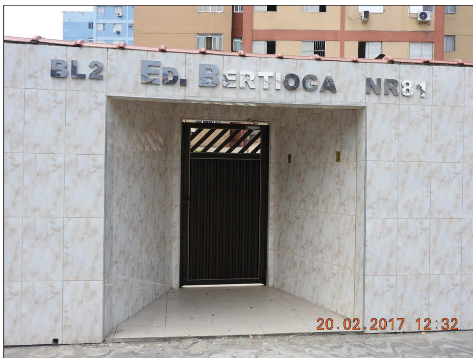
Foto 3 – Portão de acesso ao edifício.
