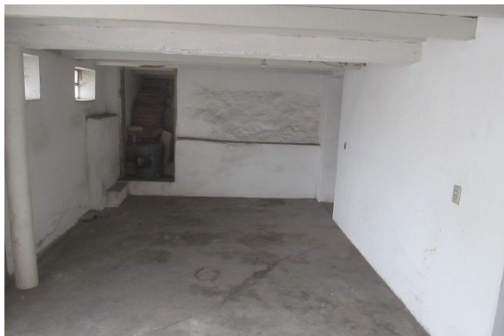
Figura 19 – Vista interna - garagem.
