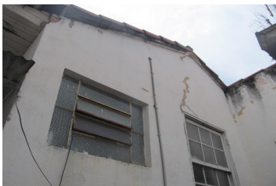
Figura 13 – Vista externa – Elevação fundos.
