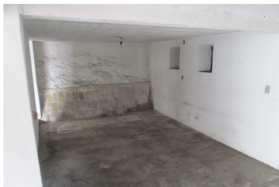
Figura 18 – Vista interna - garagem.
