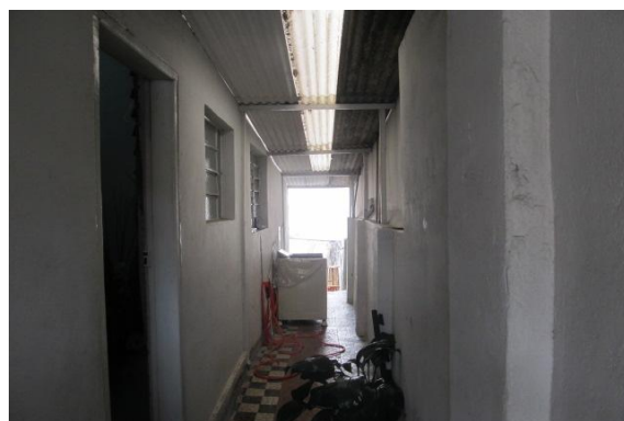
Figura 14 – Vista externa – área de circulação.
