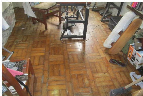
Figura 8 – Vista interna – dormitório/serviço.
