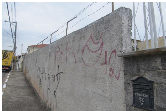
Figura 12 – Muro frontal dos imóveis.
