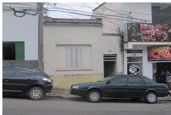
Figura 2 – Vista frontal do imóvel avaliando.
