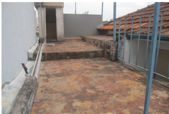
Figura 15 – Vista externa - terraço.
