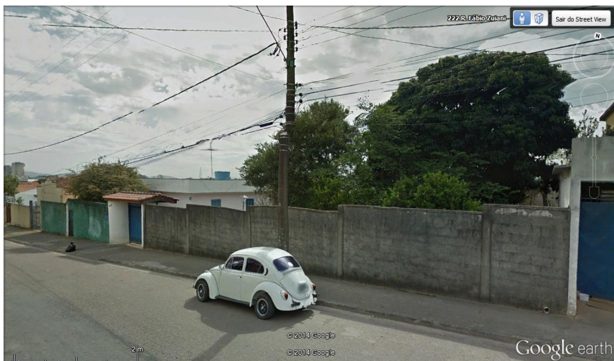
Vista do local onde situado o imóvel objeto na matrícula nº 22594, 22595 e 22596 – Imagem Google earth.
