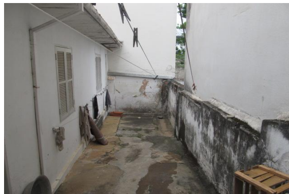
Figura 12 – Vista externa – edícula.
