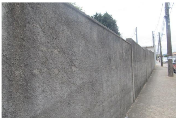
Figura 5 – Muro frontal dos imóveis.
