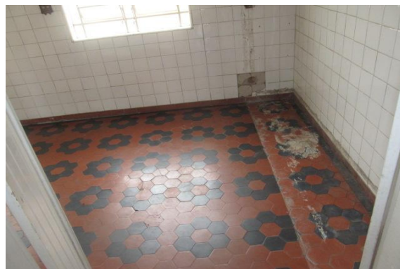
Figura 8 – Vista interna - cozinha.
