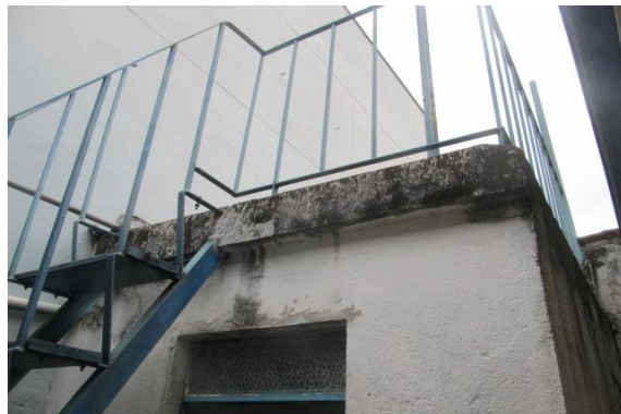
Figura 14 – Vista externa - terraço.
