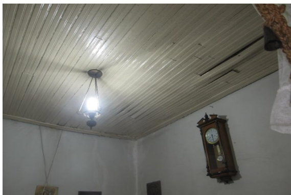
Figura 3 – Vista interna - sala.
