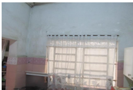
Figura 6 – Vista interna - cozinha.
