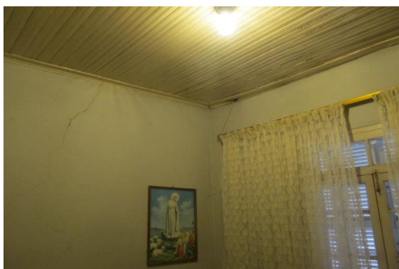
Figura 5 – Vista interna - dormitório.
