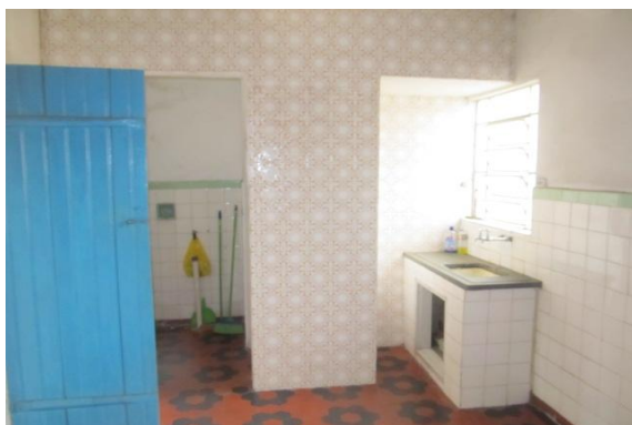
Figura 9 – Vista interna - cozinha.
