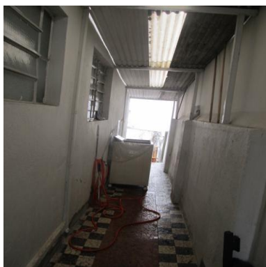
Figura 11 – Vista externa – área de circulação.
