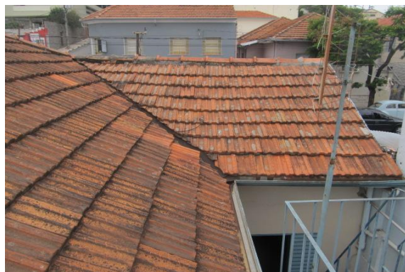
Figura 16 – Vista externa - telhado.
