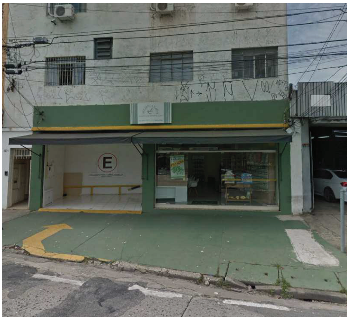
VISTA DA FACHADA DO IMÓVEL AVALIANDO.
