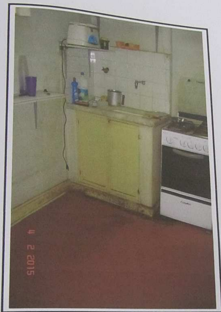
Foto nº 07: Vista da copa/cozinha. Suas principais características construtivas são: piso cerâmico, paredes revestidas em massa pintadas em látex, forro em laje e esquadrias de ferro.
