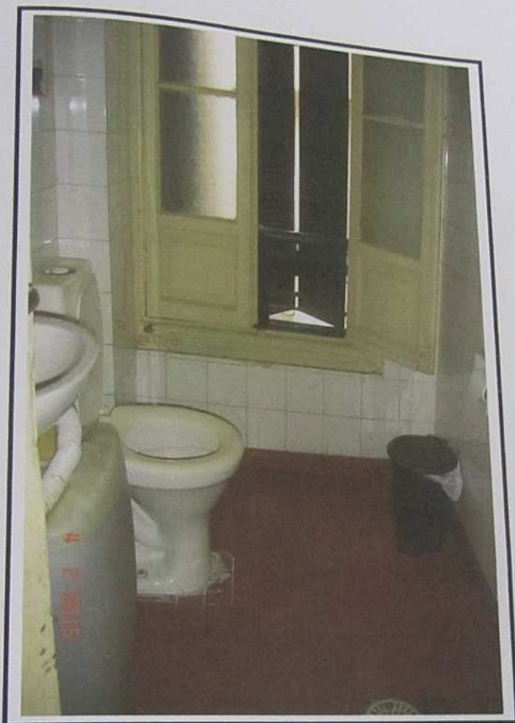
Foto nº 08: Vista do banheiro. Suas principais características construtivas são: piso em carpete de madeira, paredes azulejadas até o teto, forro em laje e esquadrias de madeira com vidro.
