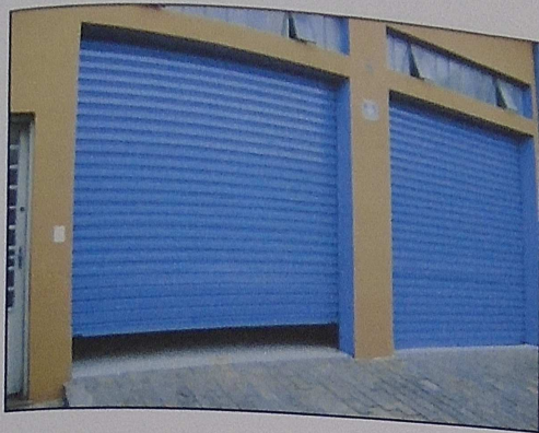
Foto 04: Entrada do galpão
