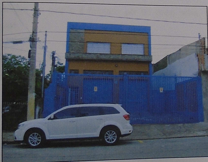
Foto 01: Vista da fachada
