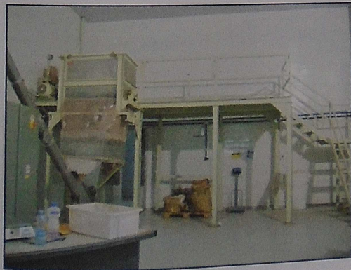
Foto 08: Interior do galpão
