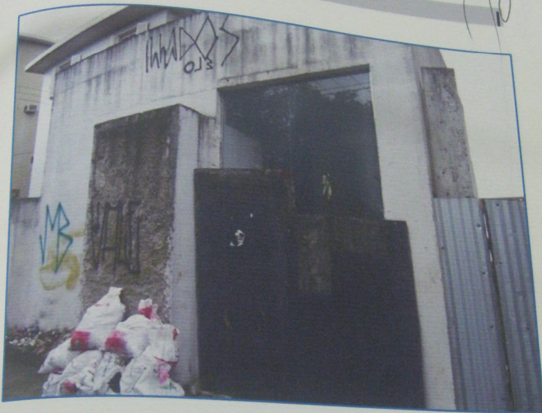
VISTA DA PEQUENA CONSTRUÇÃO EXISTENTE NO IMÓVEL AVALIANDO.
