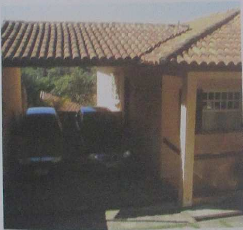
Frente da residência - garagens
