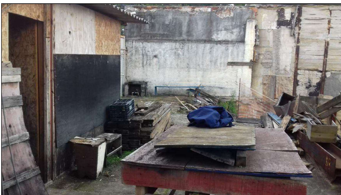
TRECHO PLANO PRÓXIMO AO LOGRADOURO
