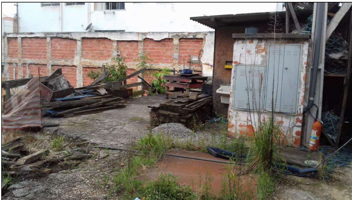
TRECHO PLANO PRÓXIMO AO LOGRADOURO
