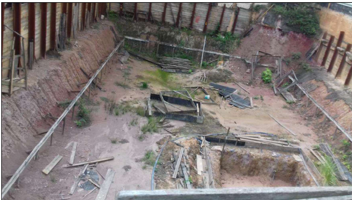
ESTÁGIO DAS ESCAVAÇÕES PARALISADAS PARA FUNDAÇÕES DE UM EDIFÍCIO
