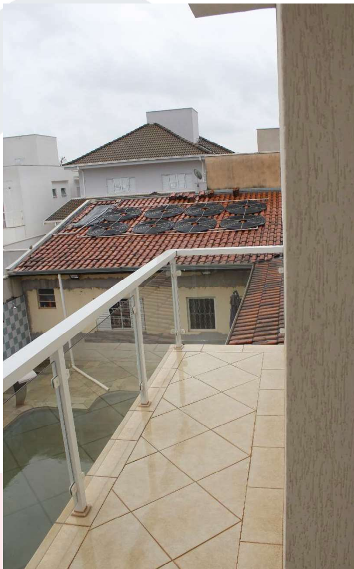
VISTA DA VARANDA DA SUITE.
