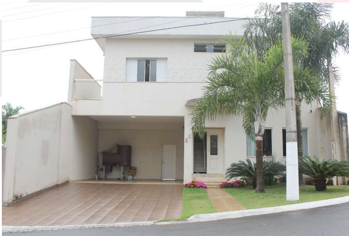
VISTA DA FACHADA DO IMÓVEL AVALIANDO.
