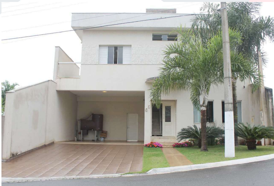
VISTA DO IMÓVEL AVALIANDO
