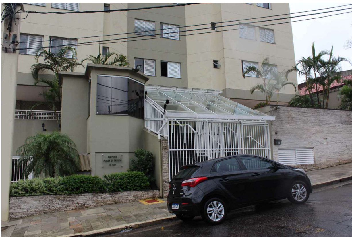
Rua Atibaia, 588 - Ap. 101(Condomínio Edifício Piazza di Treviso) – Fachada
