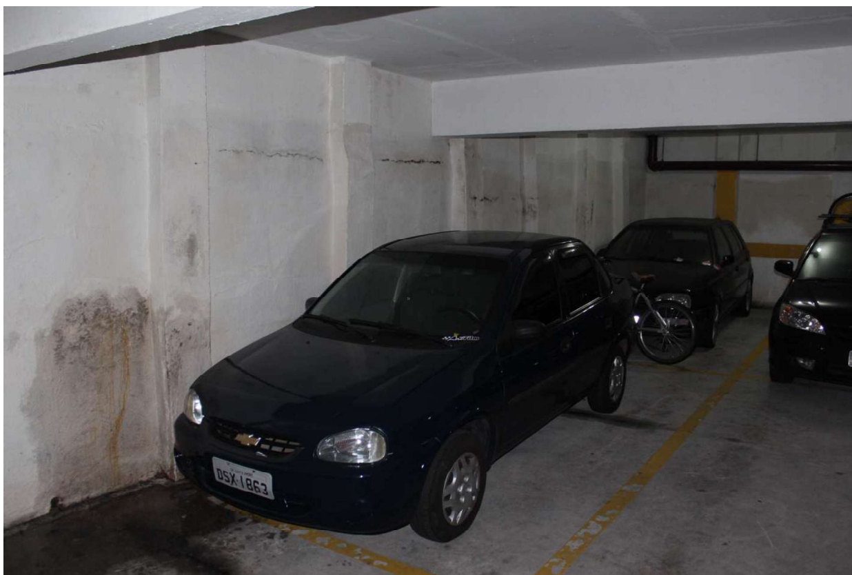
Rua Atibaia, 588 - Ap. 101(Condomínio Edifício Piazza di Treviso) – Vagas de Garagem
