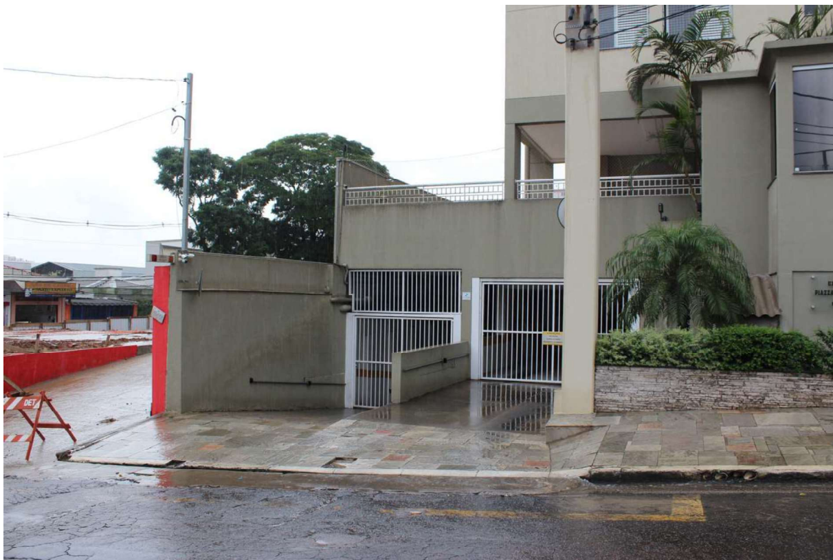
Rua Atibaia, 588 - Ap. 101(Condomínio Edifício Piazza di Treviso) – Entrada da Garagem
