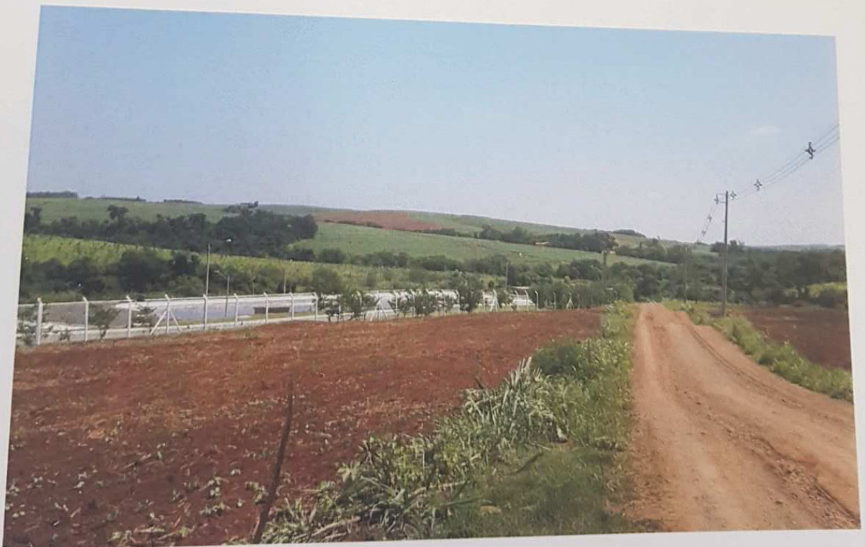
Estrada Municipal Roque Antunes Fragoso, o fundo ETE/SABESP-Boituva/SP (foto 19)
