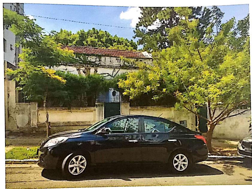
FOTO 1 e 2) – Vistas dos confrontantes dos edifícios Condomínio em epigrafe.
