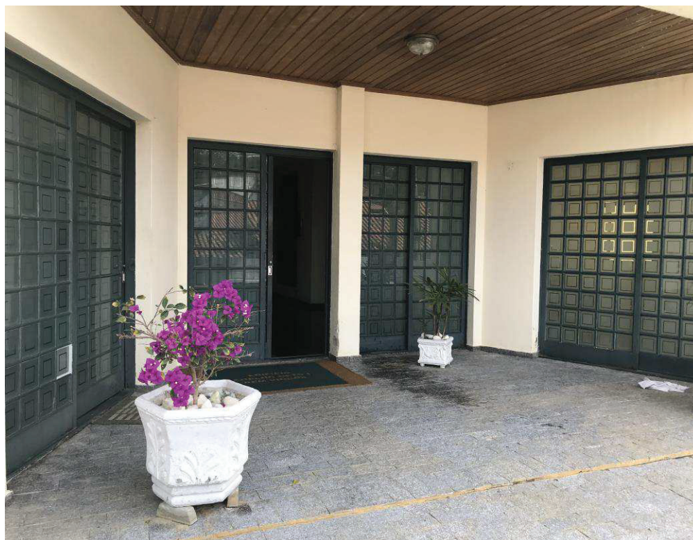
Entrada do Prédio
