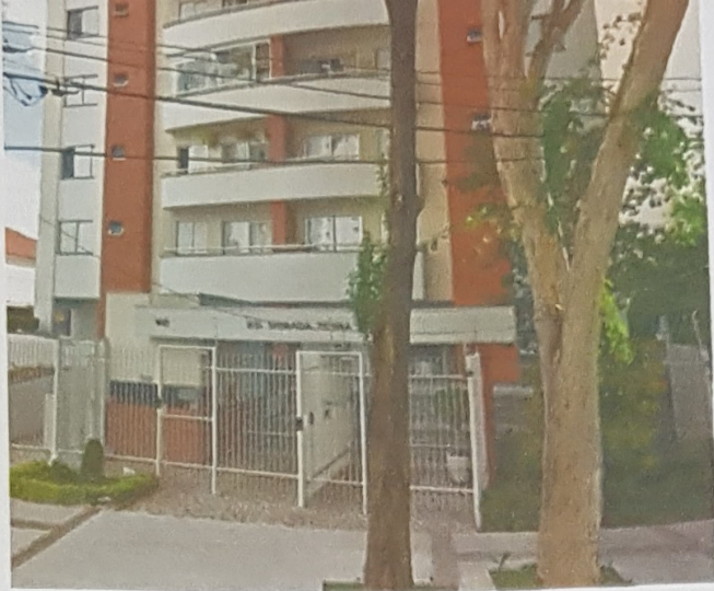
Fachada do prédio
