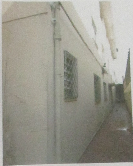
FOTO 04: -Corredor de acesso ao apartamento n°03.
