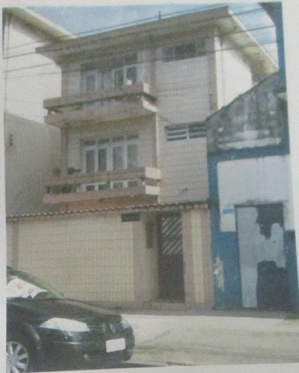
FOTO 02:- Vista do prédio.
