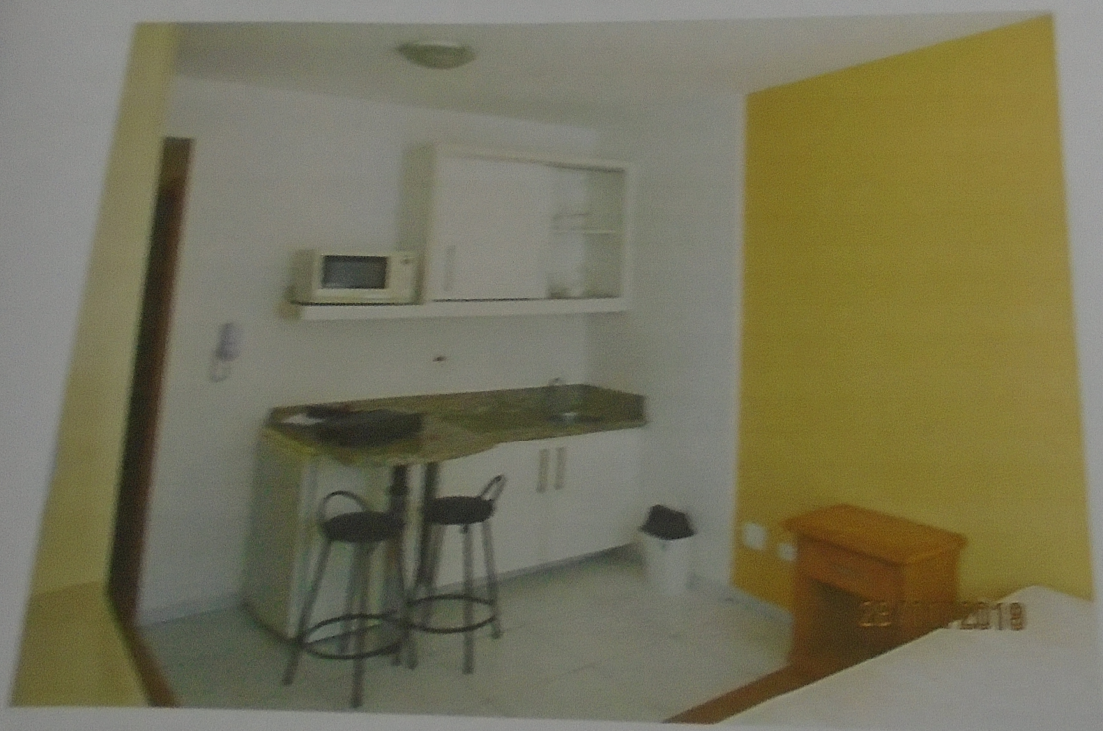
Foto 18) Vista da área destinada a cozinha. Ob- servar pia com tampo e frontão em granito, piso cerâmico e paredes a látex sobre massa corrida.
