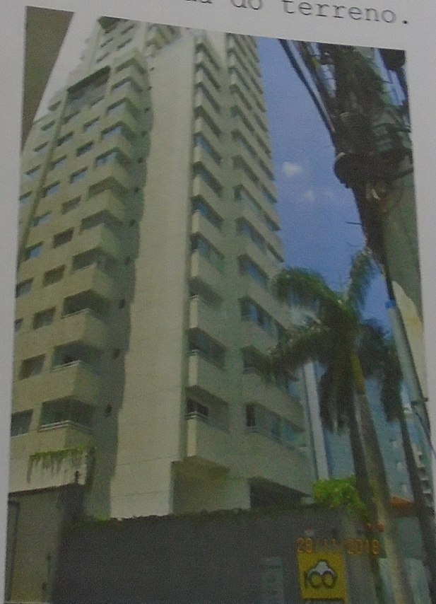
Foto 04) Vista da elevação do edifício "New Studio Pinheiros", contando com 03 (três) subsolos, piso térreo, sobreloja e 17 (dezesete) andares residenciais.
