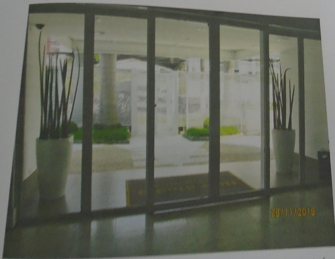
Foto 06) Vista do interior do piso térreo do edifício. Observar acabamento de piso e paredes.
