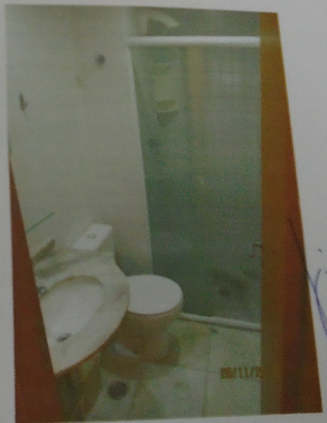
Foto 16) Vista do banheiro. Observar acabamento de piso e paredes, pia com tampo em granito, cuba em louça e bacia sanitária com caixa acoplada.
