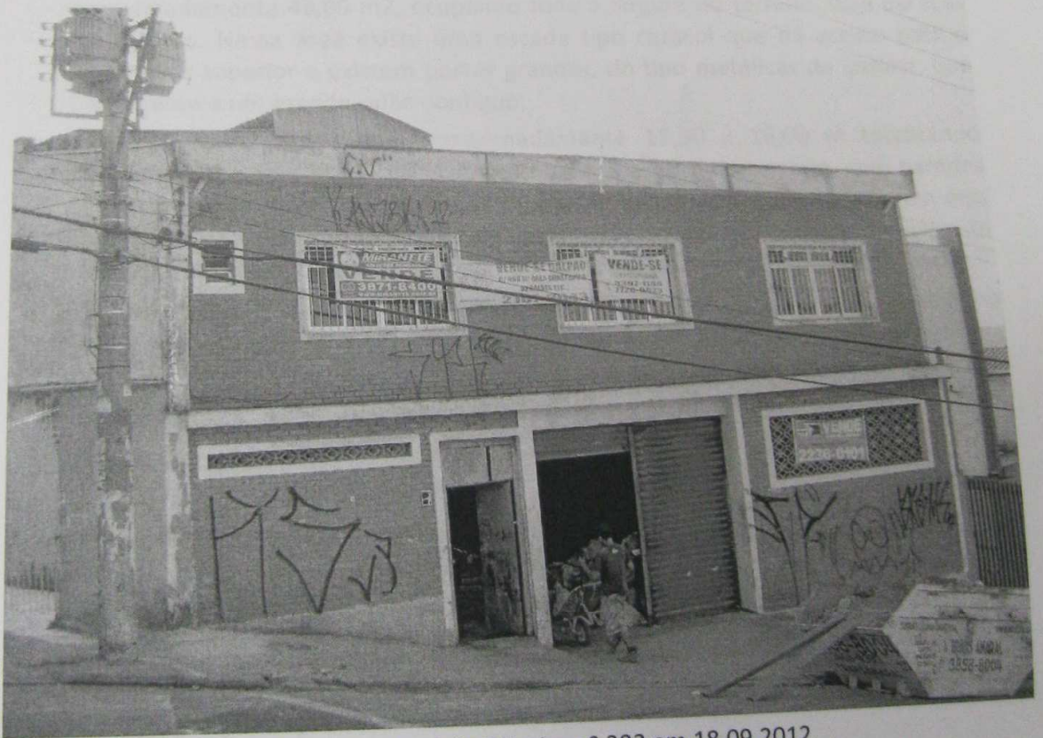
Foto 02: Fachada do imóvel - Rua José de Oliveira nº 393 em 18.09.2012.
