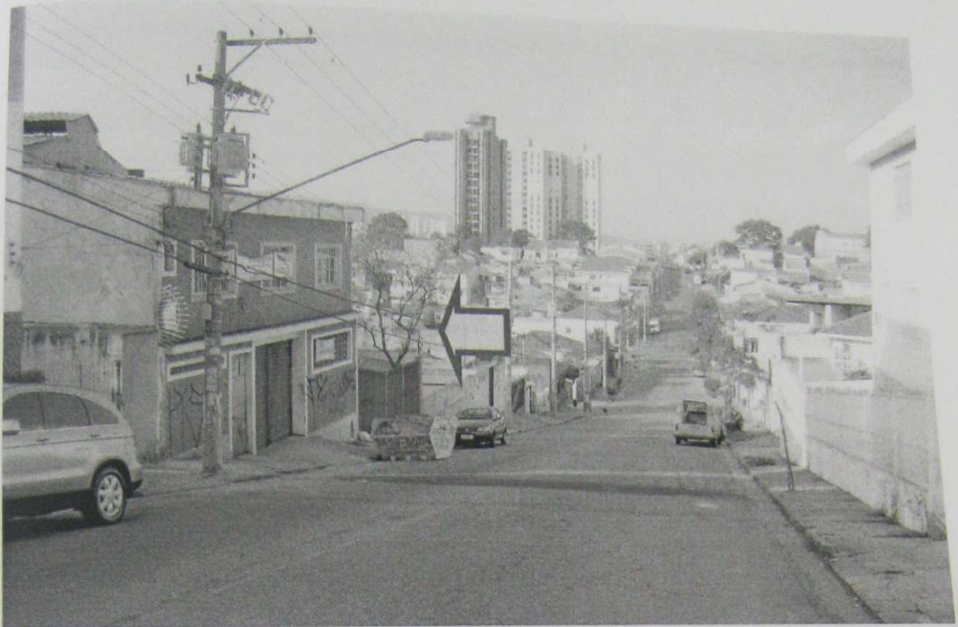
Foto 01: Vista da rua e do imóvel - Rua José de Oliveira nº 393 em 18.09.2012.
