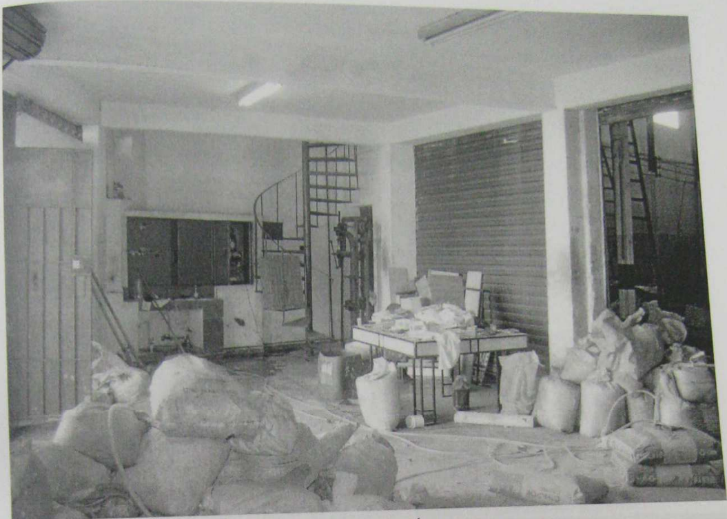
Foto 03: Sala na entrada do edifício, no pavimento térreo
