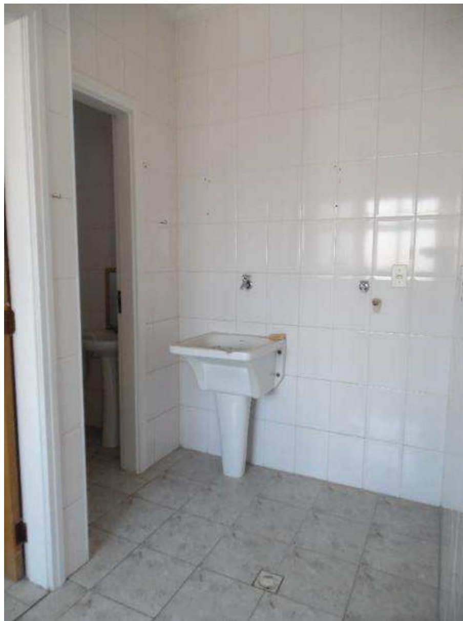
FOTO 09: - Vista da área de serviço do imóvel.
