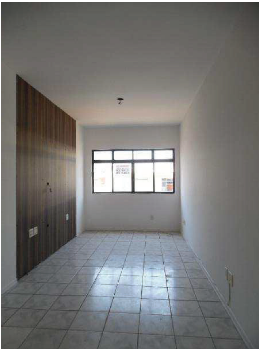
FOTO 04: - Vista da sala do imóvel.
