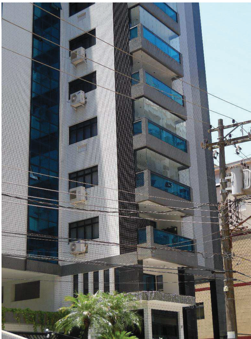
FOTO 01: - Vista da fachada do prédio.
