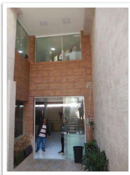
Foto nº 39 - Vista da porta de acesso aos subsolos dos Imóveis 1 e 2 .
