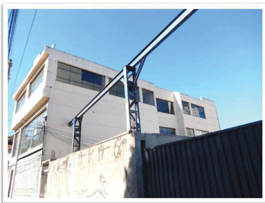
Foto nº 51 - Vista da fachada lateral esquerda do Imóvel 2 .
