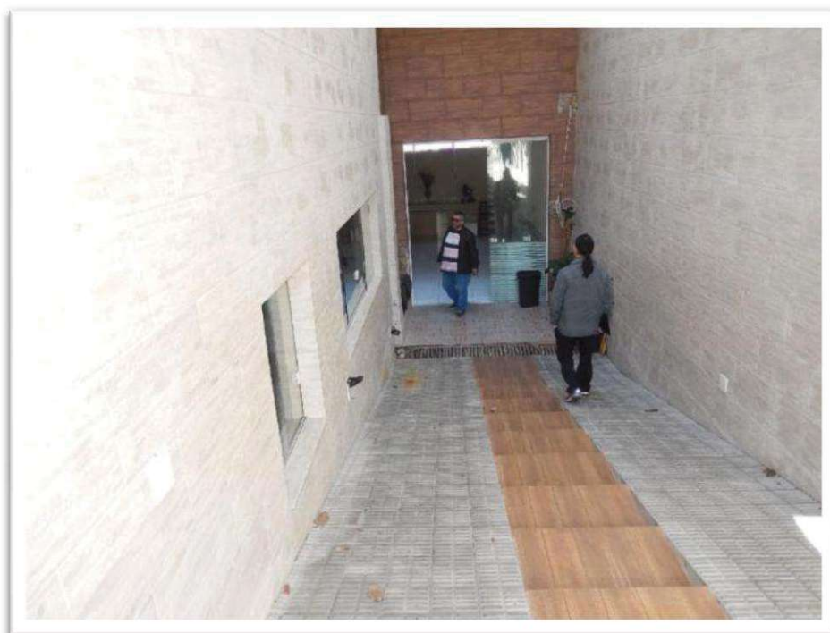
Foto nº 38 - Vista da rampa de acesso aos subsolos dos Imóveis 1 e 2 .
