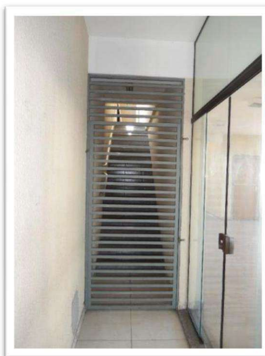
Foto nº 55 - Vista parcial interna do Imóvel 2.
