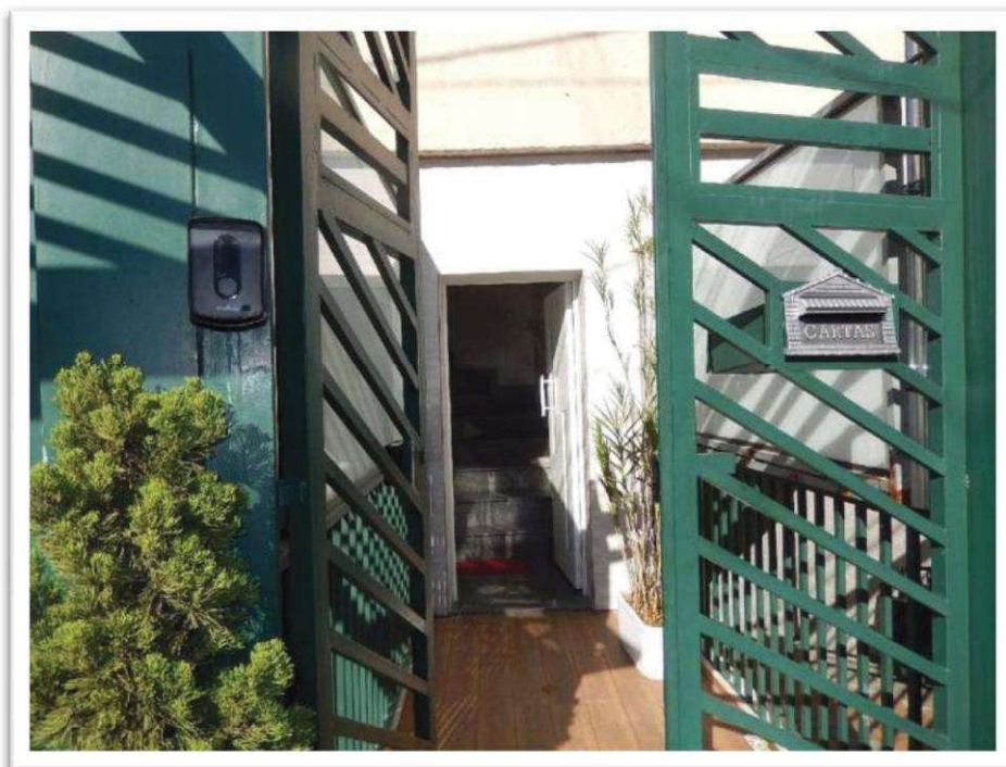
Foto nº 4 - Vista do portão de acesso ao Imóvel 1 , ao fundo a porta de acesso à residência localizada no 1º pavimento.
