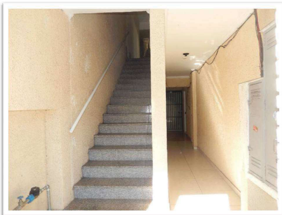
Foto nº 53 - Vista parcial interna do Imóvel 2 .
