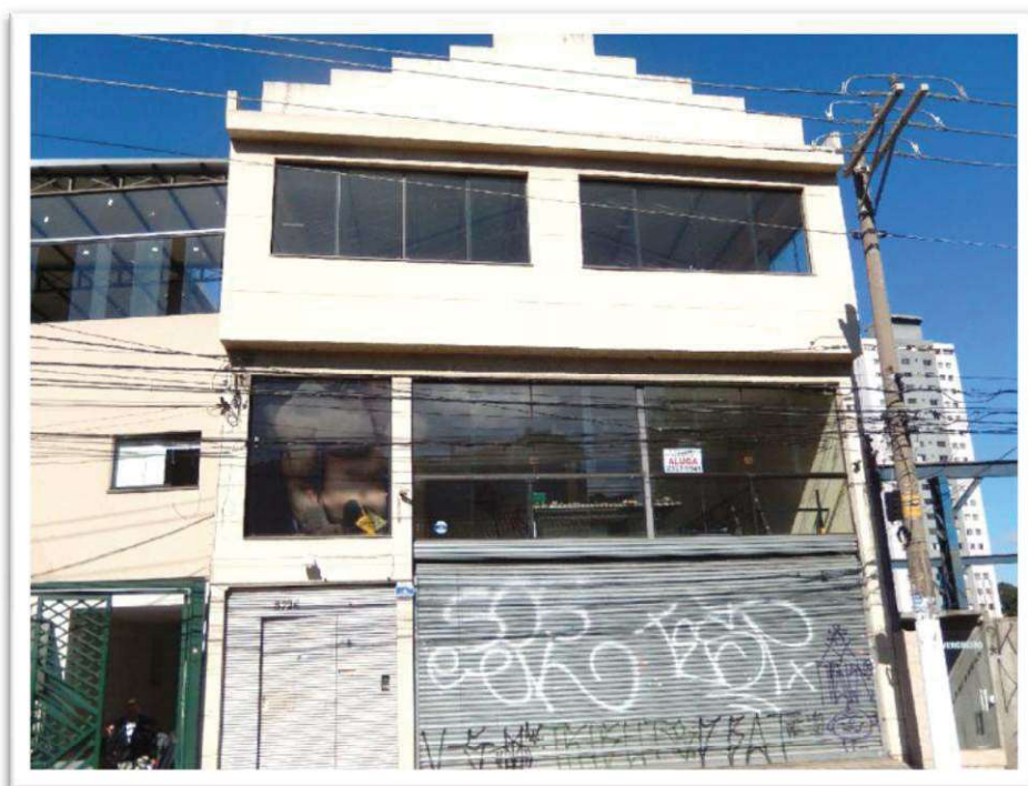
Foto nº 50 - Vista da fachada frontal do Imóvel 2 .
