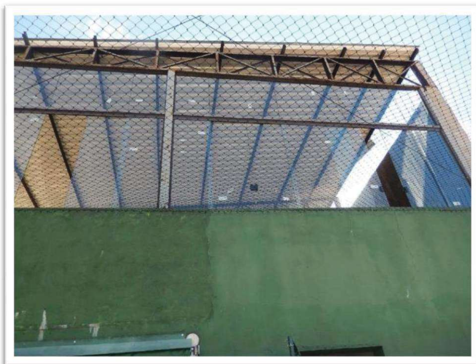
Foto nº 27 - Vista parcial do 1º pavimento do Imóvel 1 – Fachada dos fundos do Pavimento da Cobertura.
