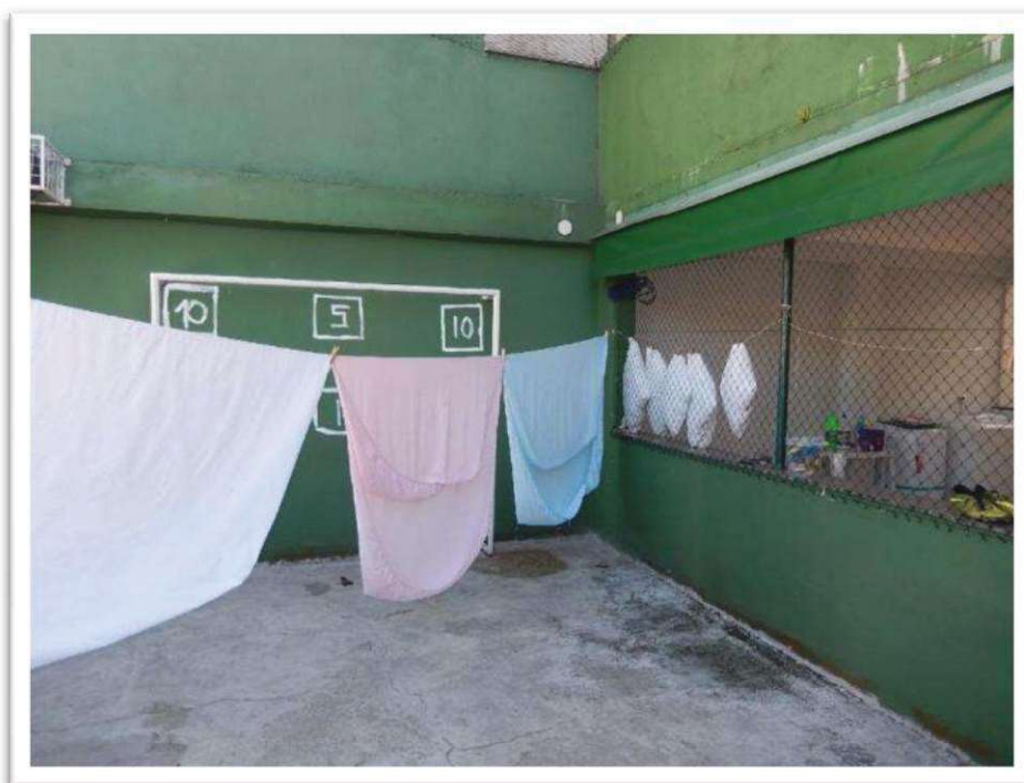
Foto nº 26 - Vista parcial do 1º pavimento do Imóvel 1 – Área descoberta aos fundos.
