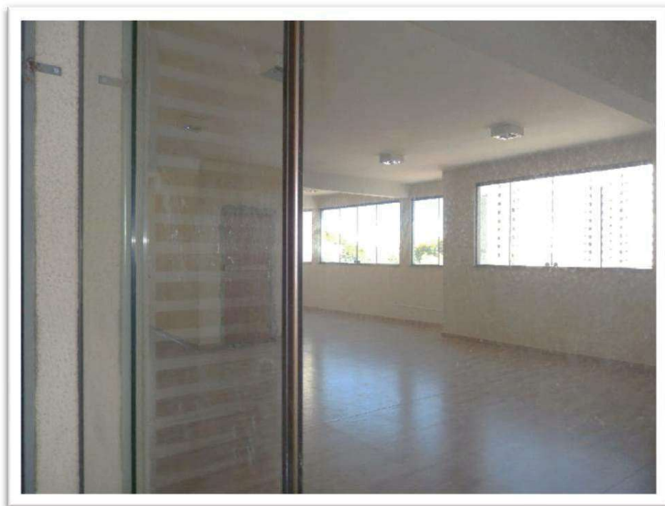
Foto nº 57 - Vista parcial interna do Imóvel 2 .
