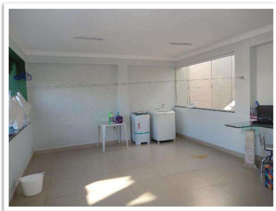
Foto nº 23 - Vista parcial do 1º pavimento do Imóvel 1 – Lavanderia.
