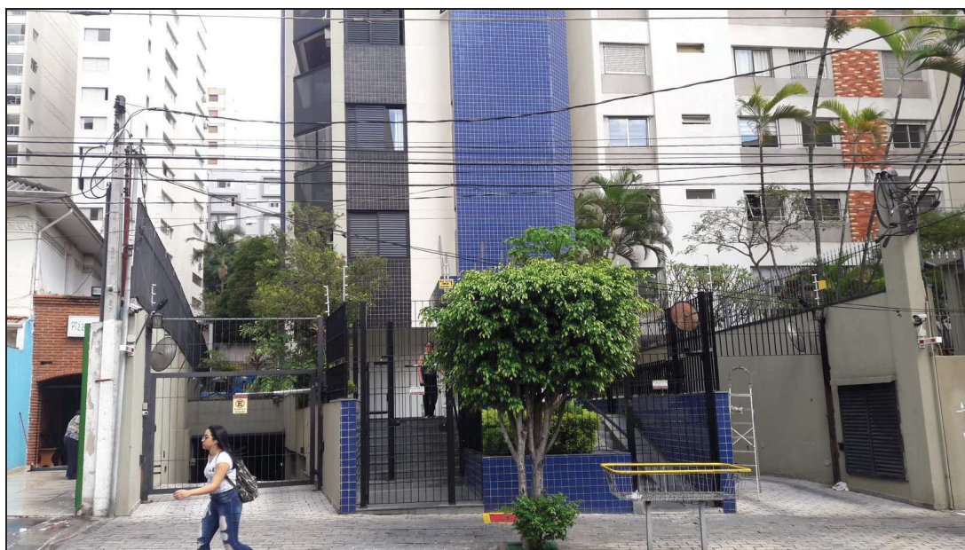
Foto 1 – Fachada do Edifício Capri
