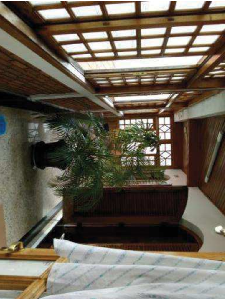
Foto 18: Primeira parte do imóvel. Varanda fechada
