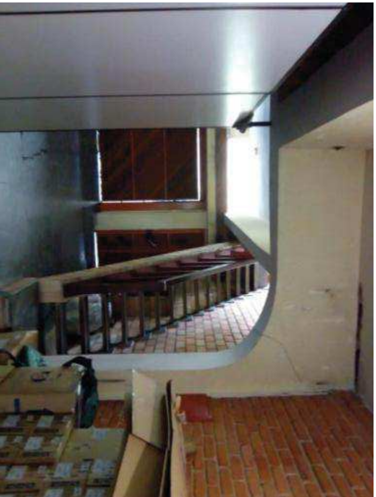
Foto 5: Escada de acesso aos cômodos da frente na garagem
