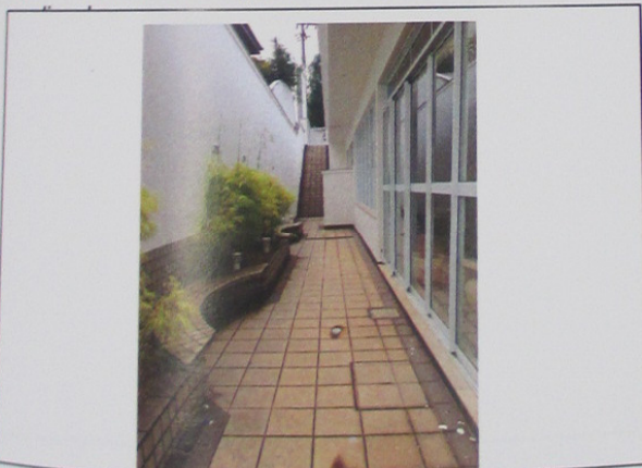
FOTO Nº 5 - Vista da edificação construída no lote vizinho interligada à área de lazer do
