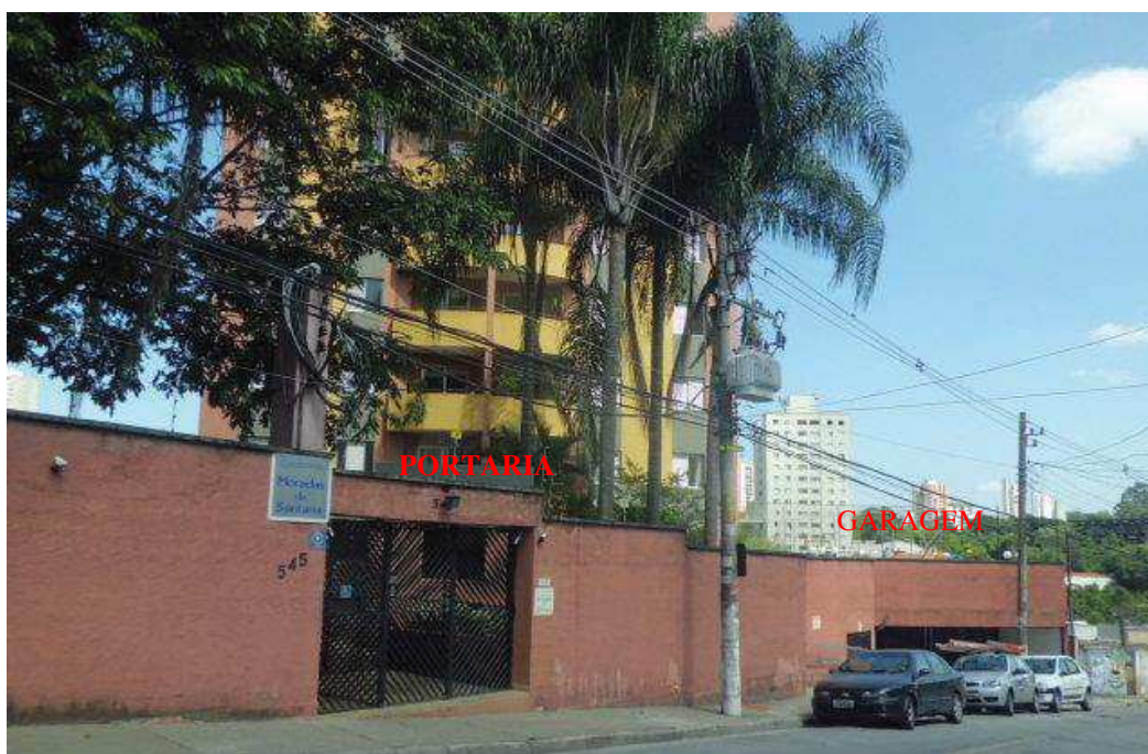
ENTRADA PORTARIA E PORTÃO PARA ACESSO SUBSOLOS.
