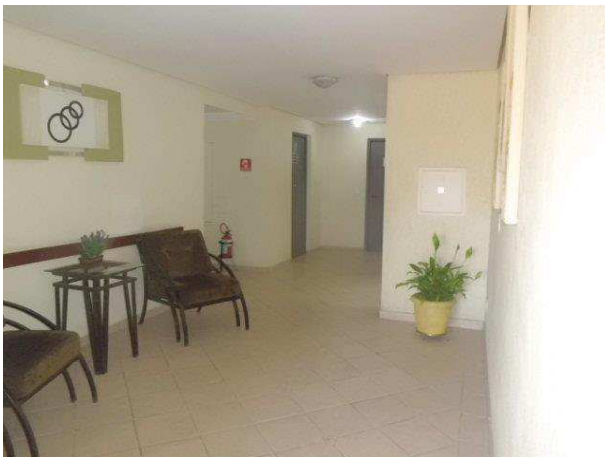
DETALHE DAS CARACTERÍSTICAS CONSTRUTIVAS DO HALL.
