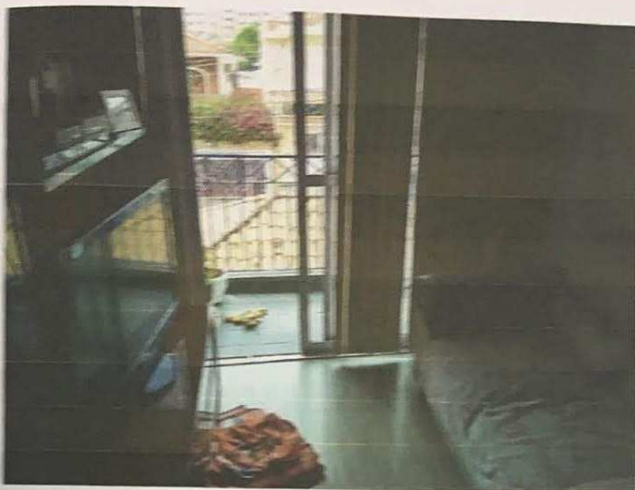
Foto 16) Outra vista da sala, agora visando a área do terraço. Observar porta balcão em alumínio anodizado natural, piso em ardósia cinza e fechamento em gradil metálico.
