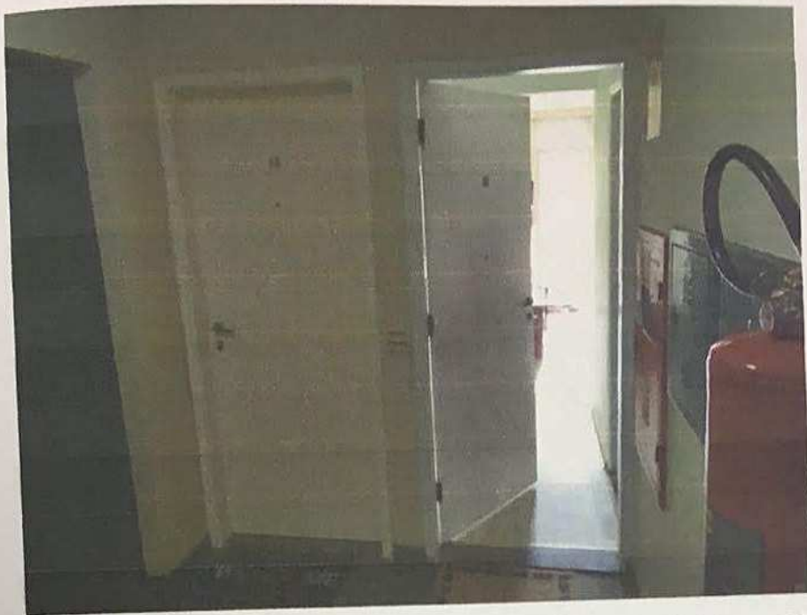
Foto 12) Vista do hall no 1º andar. Observar acabamento e porta de entrada da unidade avaliada.
