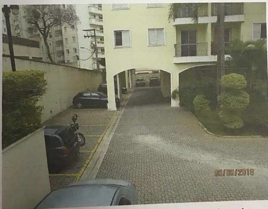
Foto 05) Vista de parte da periferia do residencial. Observar áreas ajardinadas e piso em bloquetes de cimento intertravados.
