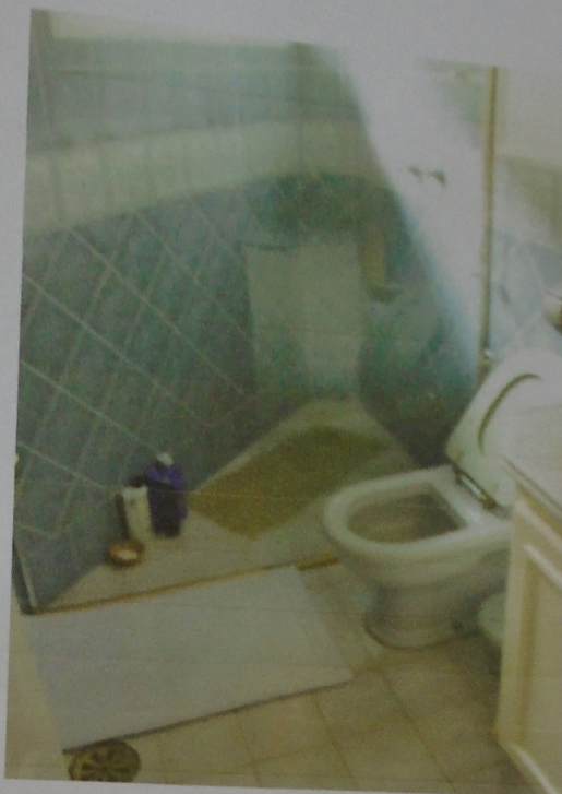
Foto 27 – Banheiro da suíte 04
