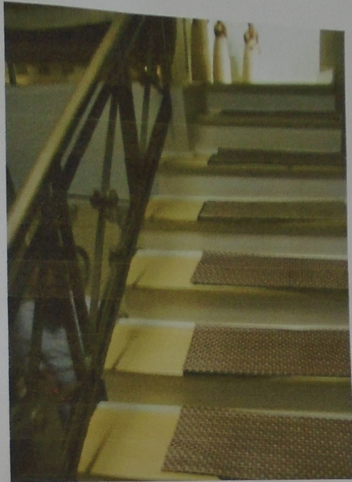
Foto 17 – Escada de acesso ao pavimento superior
