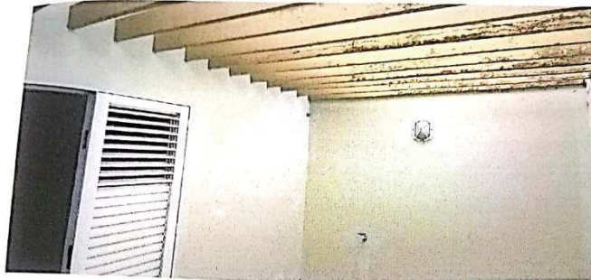
Foto 25 - Vista parcial poço de iluminação e ventilação quarto II
