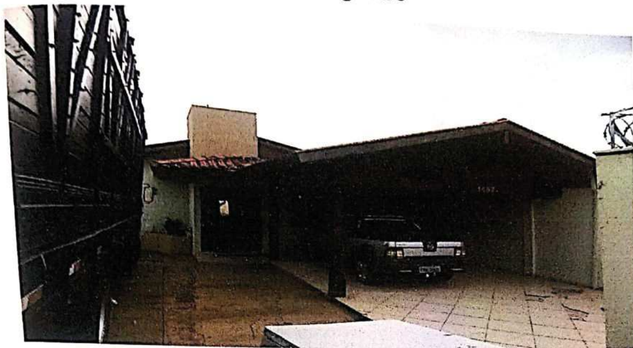
Foto 01 – Vista geral frente entrada de veículo e garagem
