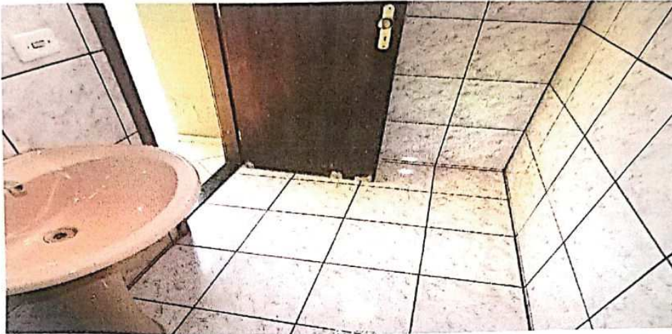
Foto 46 – Parcial banheiro edícula
