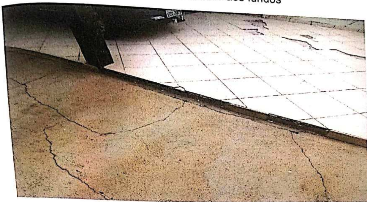
Foto 06 – Porta de acesso aos fundos
