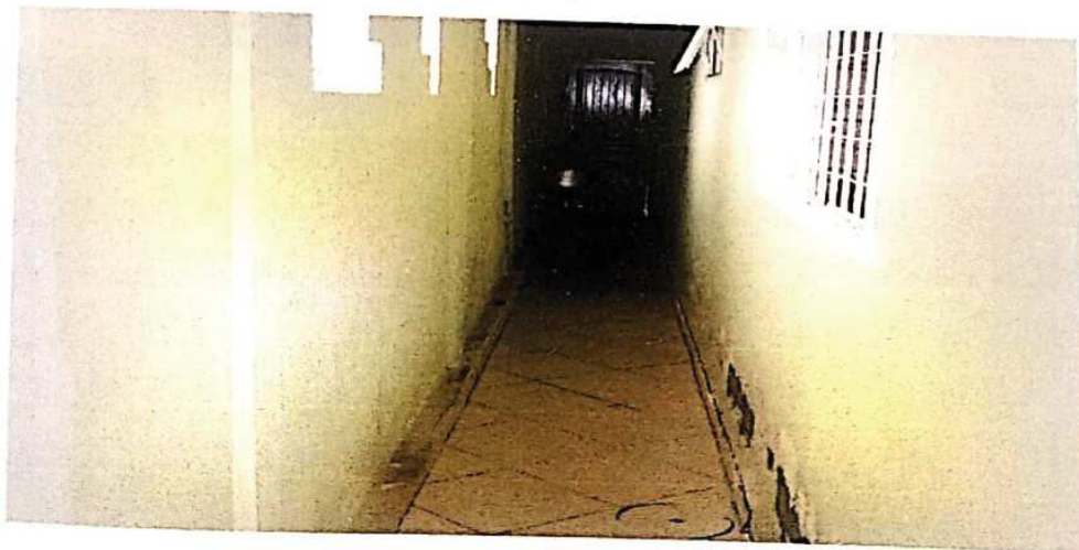
Foto 48 – Vista corredor lateral
