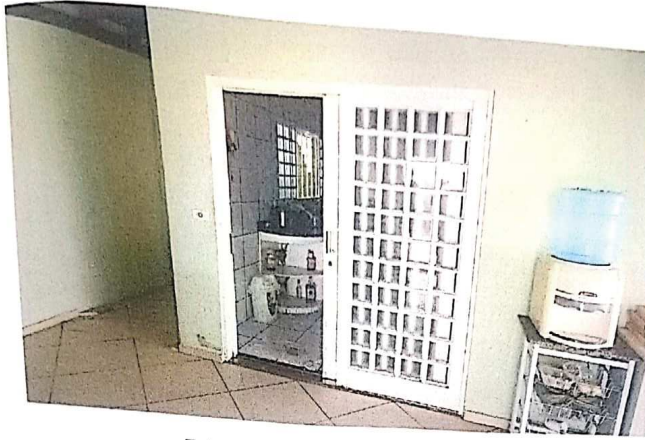
Foto 37 - Porta de acesso à cozinha
