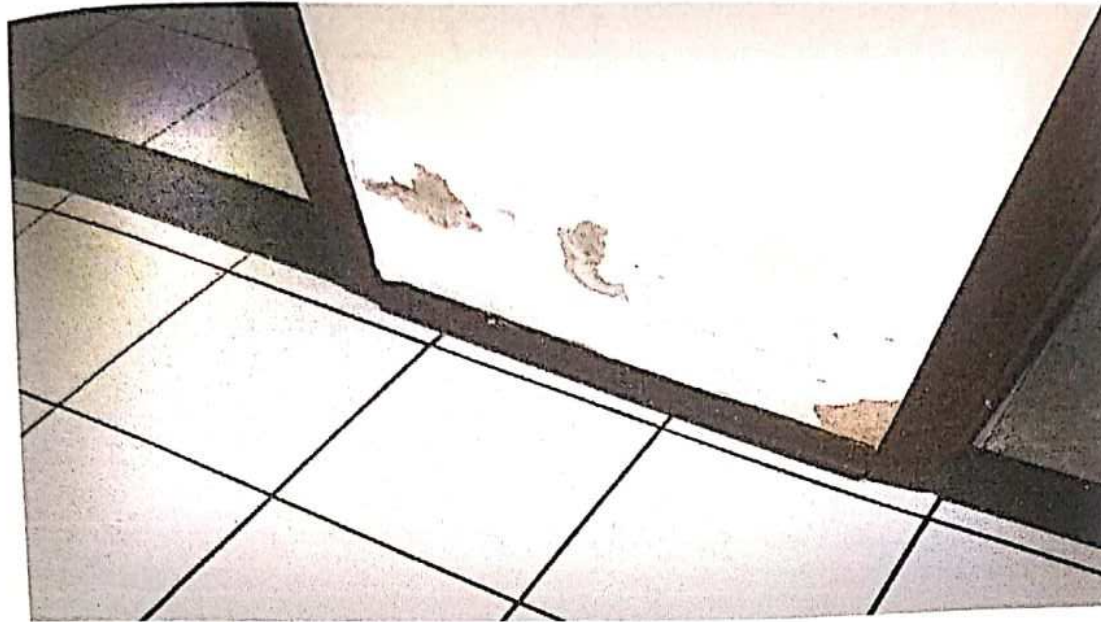
Foto 34 – Detalhe reboco corredor
