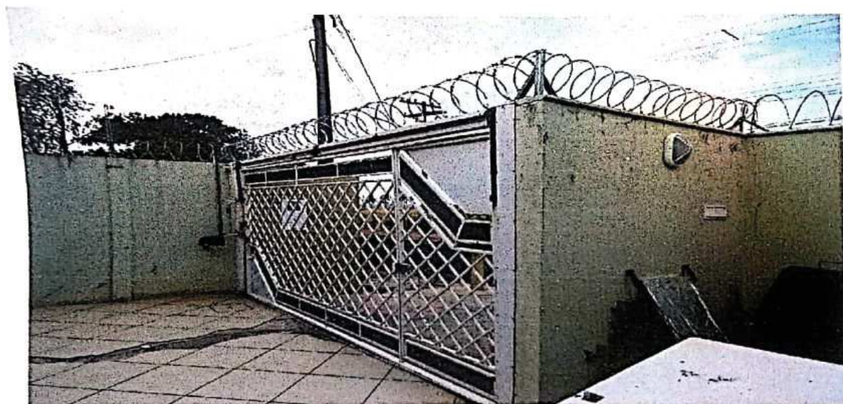
Foto 08 – Vista geral interna portão de acesso
