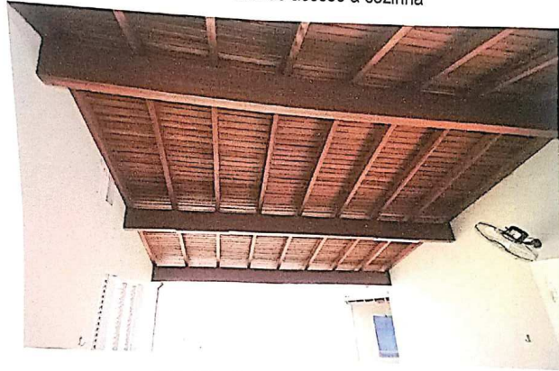
Foto 38 - Cobertura área dos fundos
