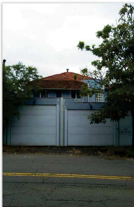
Foto 01 – Vista geral da fachada do imóvel penhorado.
