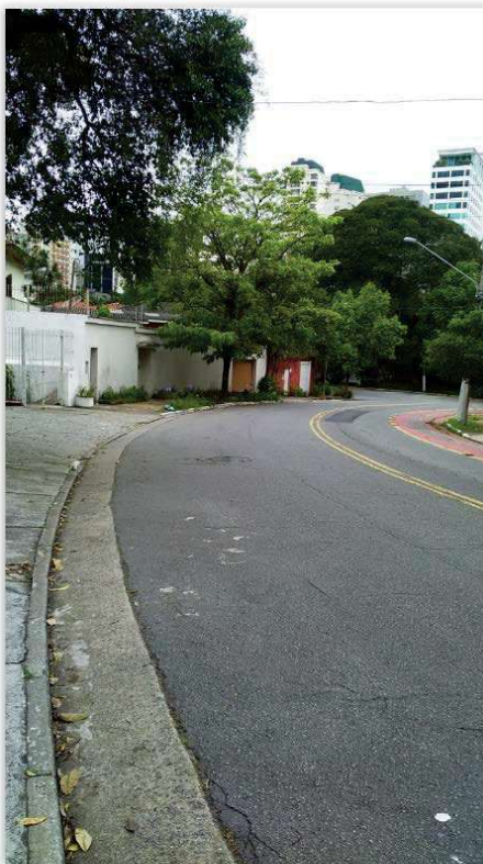
Foto 03 - Vista geral do entorno do imóvel e suas melhorias.
