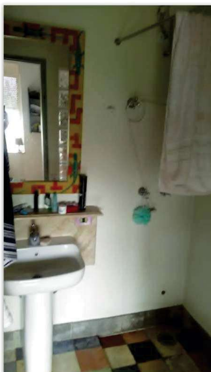
Foto 28 – Vista do banheiro do primeiro dormitório do imóvel penhorado.
