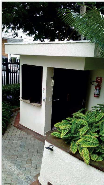
Foto 05 - Vista geral da portaria do Edifício.
