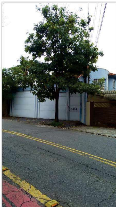
Foto 02 – Vista geral da fachada do imóvel penhorado.
