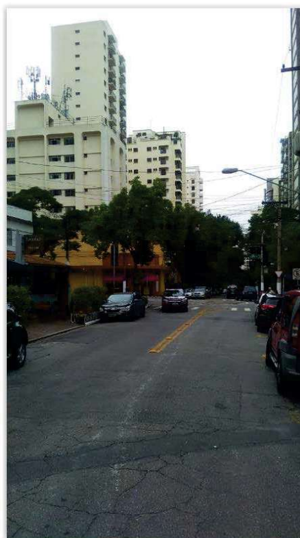
Foto 03 – Vista geral do entorno do Edifício e suas melhorias.
