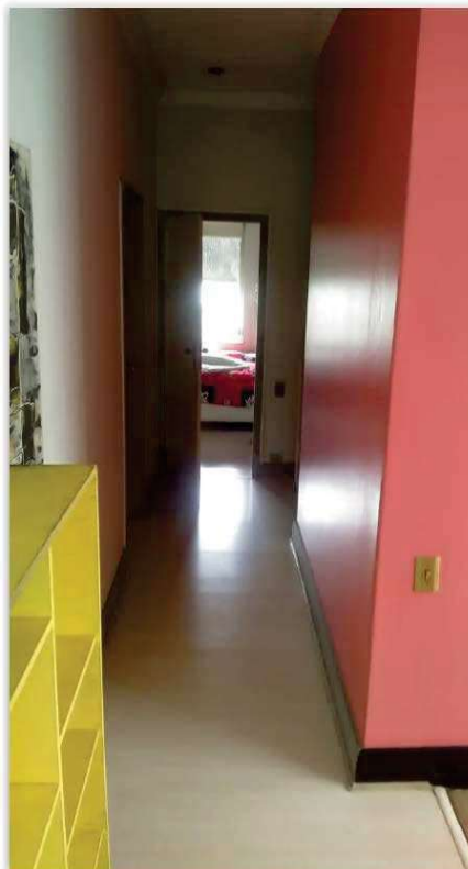
Foto 25 – Vista do corredor de acesso aos dormitórios no pavimento superior do imóvel penhorado.
