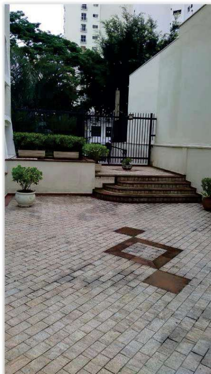
Foto 06 - Vista geral do passeio na área comum do Edifício.
