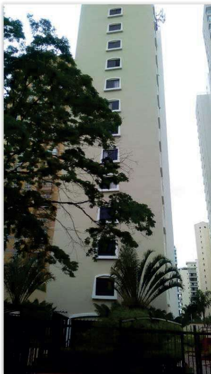
Foto 01 - Vista geral da fachada do Edifício Anapurus.
