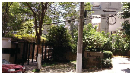
Representação Fachada Descrição Data Foto 28/11/2018
