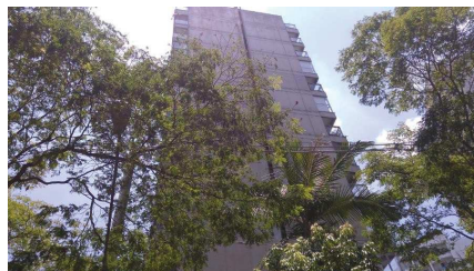
Representação Fachada Descrição Data Foto 28/11/2018
