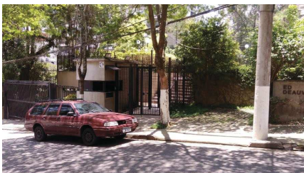
Representação Fachada Descrição Data Foto 28/11/2018
