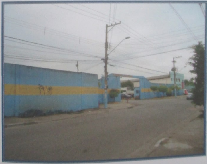
Vista da frente do imóvel avaliando.
