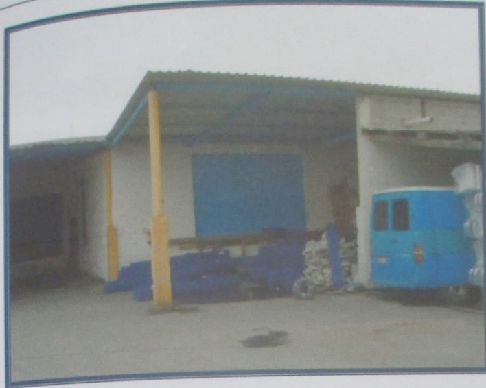
Vista externa do galpão 2.
