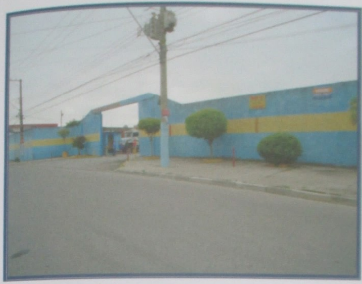
Vista da frente do imóvel avaliando.
