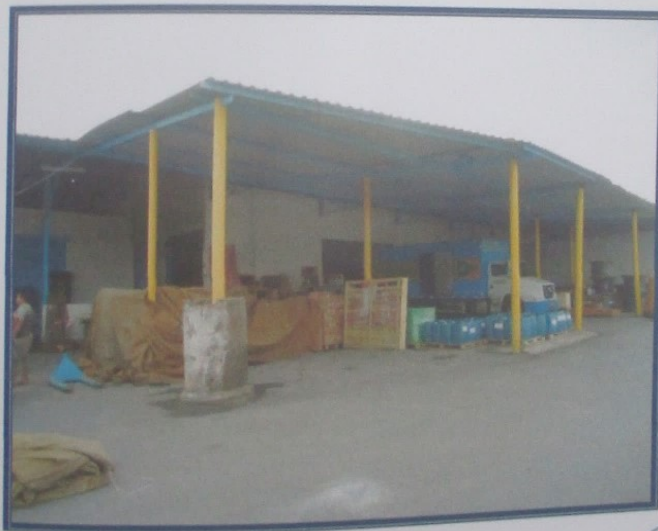
Vista externa do galpão 1.
