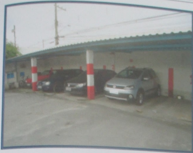
Vista externa do estacionamento coberto.
