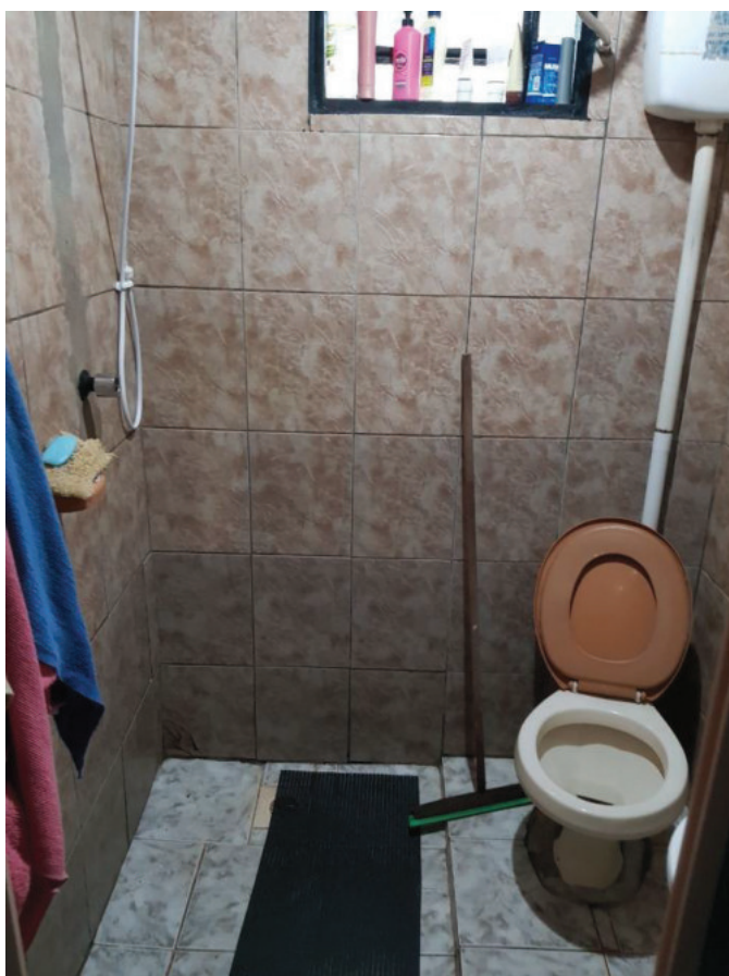
Foto 6 – Detalhe do banheiro;
