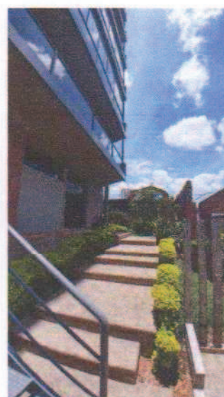
Recuo Frontal do Prédio
