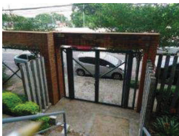
Portão de entrada
