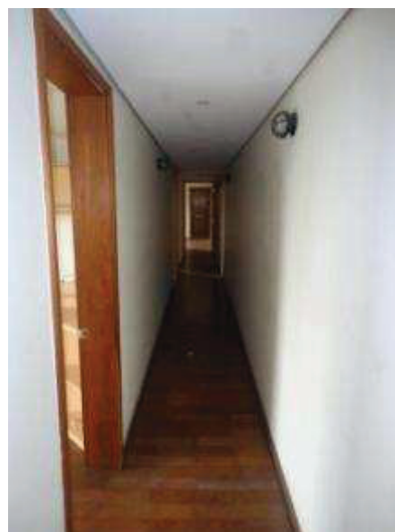
Área de serviço, quarto de empregada com banheiro e corredor de circulação
