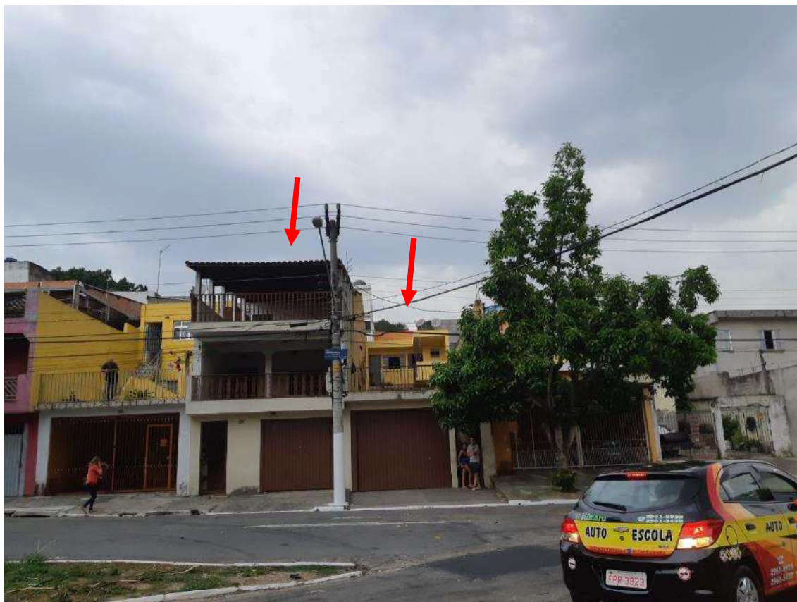
FOTO N° 4: Vista a partir de outro ângulo da fachada do Imóvel 1, detalhe evidenciando as duas residências geminadas.
