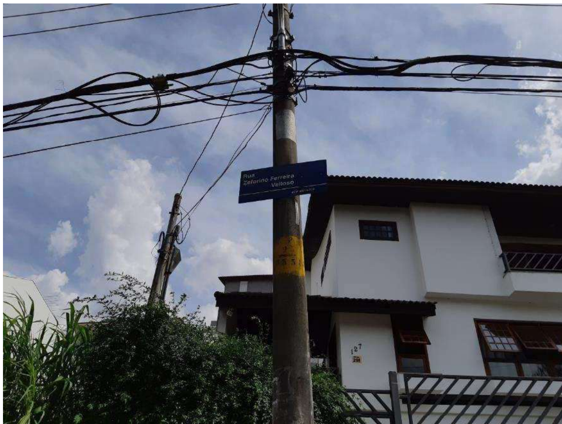
FOTO N° 12: Identificação da Rua Zeferino Ferreira Velloso, onde se localiza o Imóvel 4.
