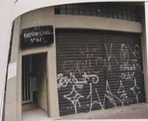
Av. Pedroso de Moraes, 645/647 Detalhe da entrada
