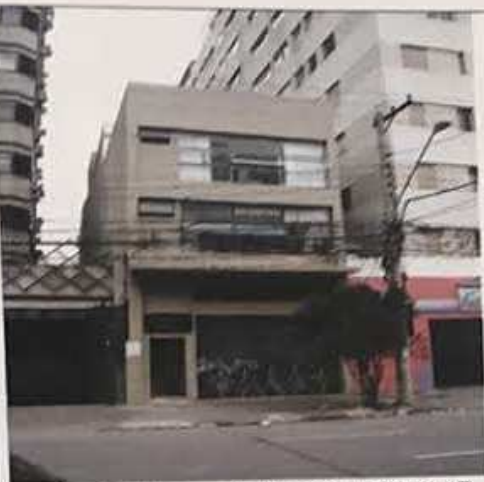
Av. Pedroso de Moraes, 645/647 Fachada
