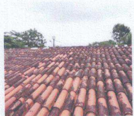
Imóvel recoberto em telhas de barro
