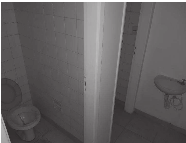
FOTO Nº 06 Vista parcial sanitários
