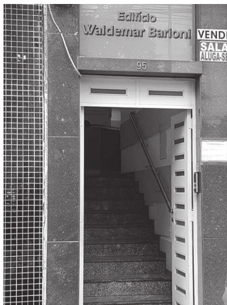
FOTO Nº 02 Vista parcial entrada do Edifício Waldemar Barioni
