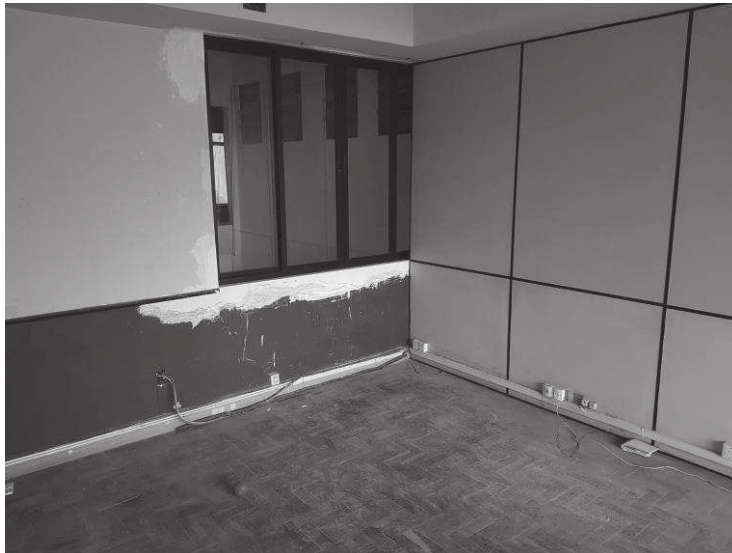
FOTO Nº 04 Vista parcial Conjunto 41 (em reforma)
