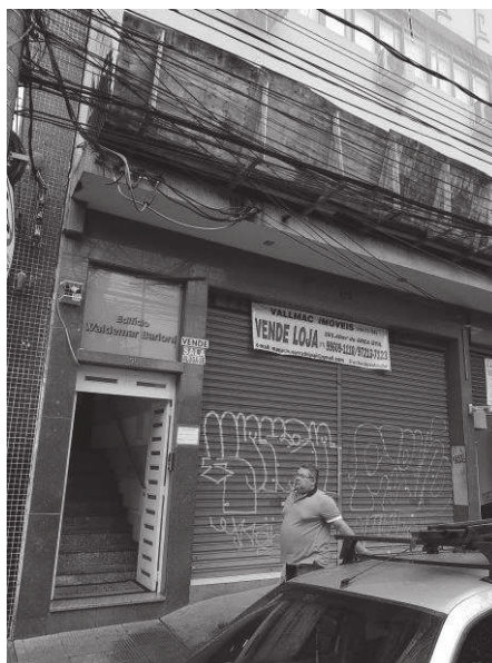
FOTO Nº 01 Vista parcial fachada Edifício Waldemar Barioni
