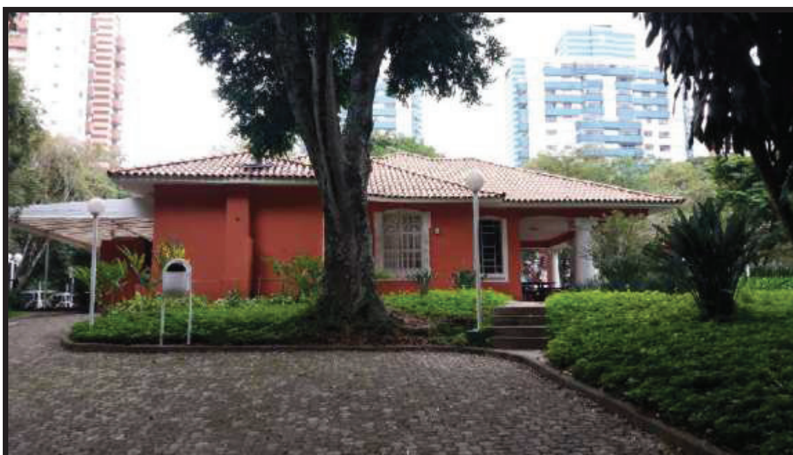
ASPECTOS GERAIS DO CONDOMÍNIO – RESTAURANTE
