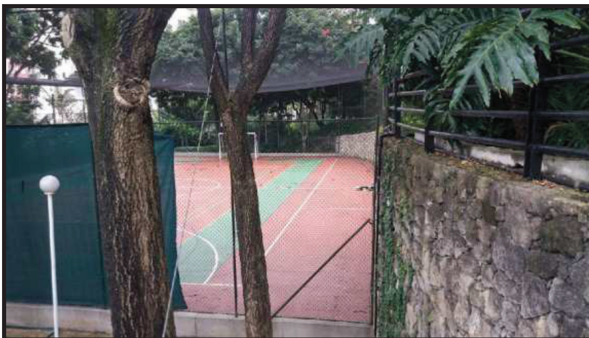
ASPECTOS GERAIS DO CONDOMÍNIO – QUADRA DESCOBERTA
