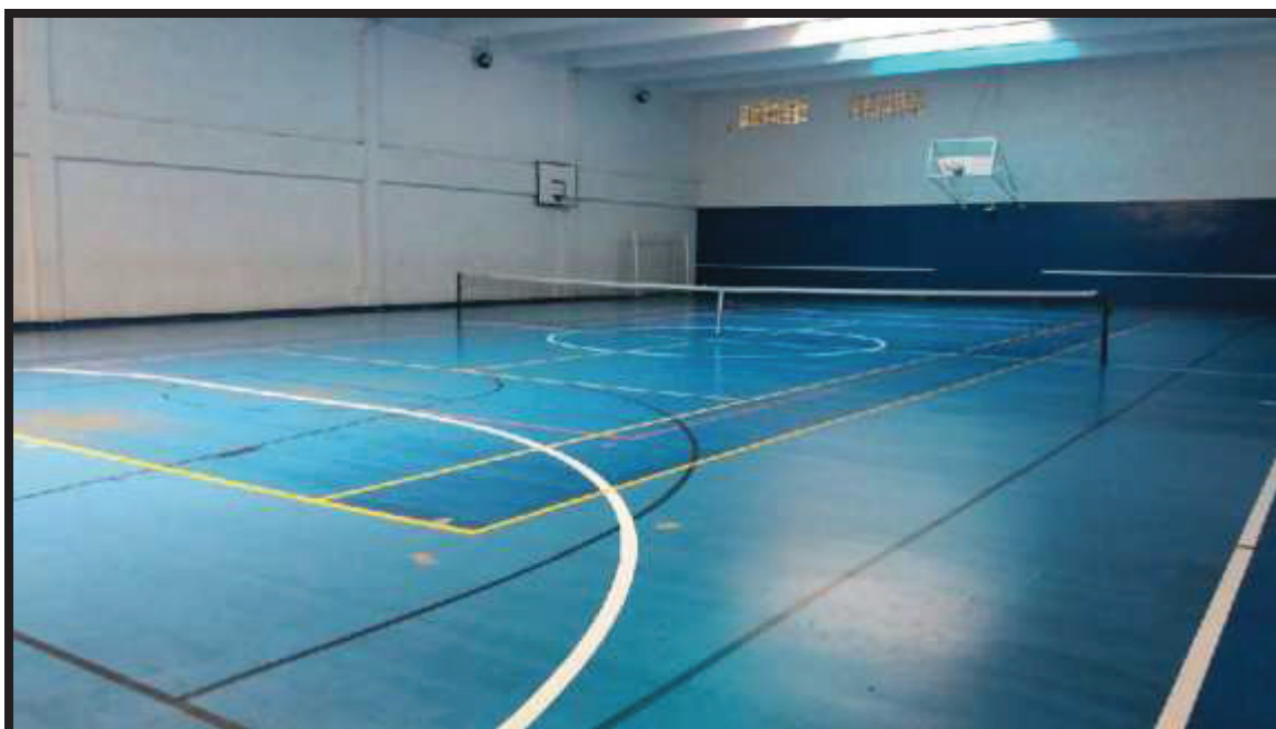
ASPECTOS GERAIS DO CONDOMÍNIO – QUADRA COBERTA
