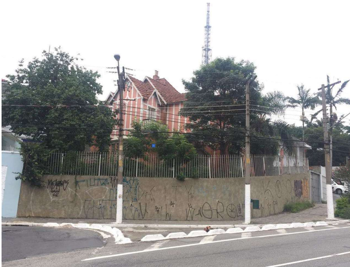
Vista da fachada frontal do imóvel.
