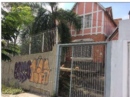
Detalhe da fachada da construção
