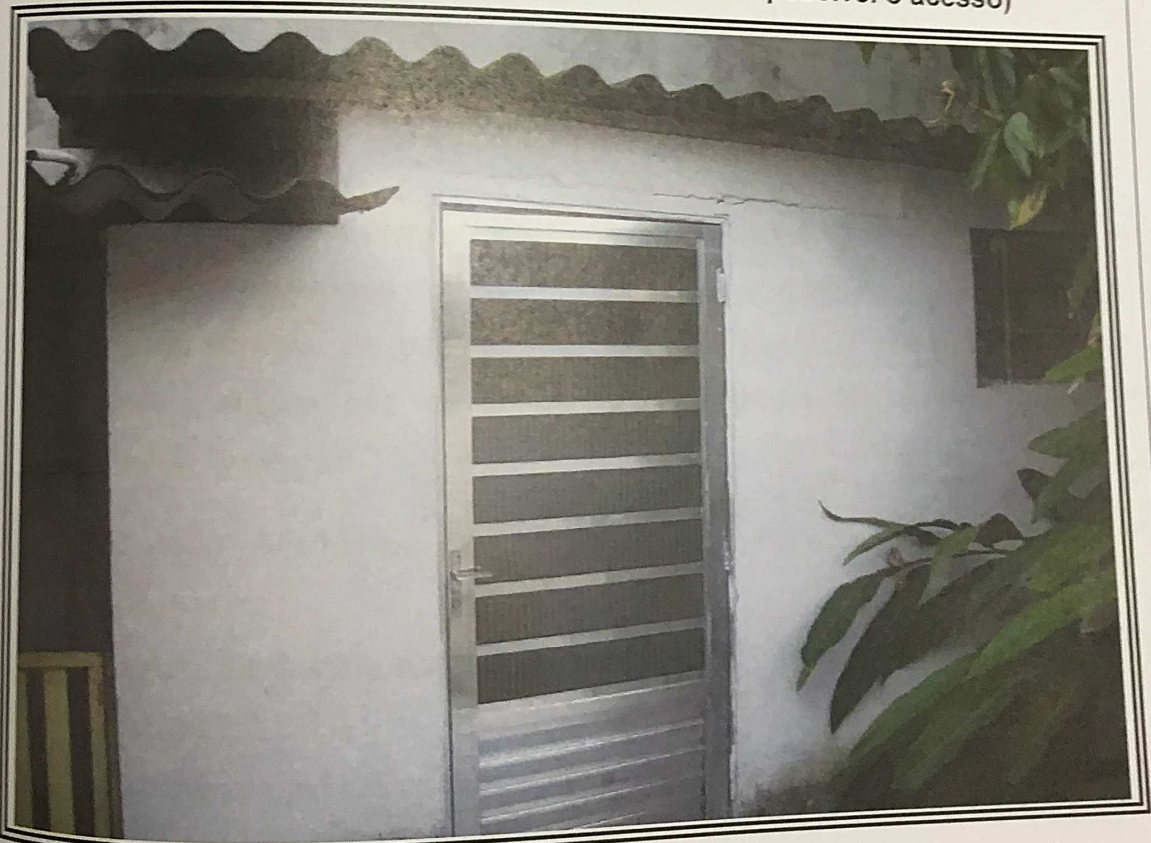
Foto n° 20: Vista do banheiro externo (não foi possível o acesso)
