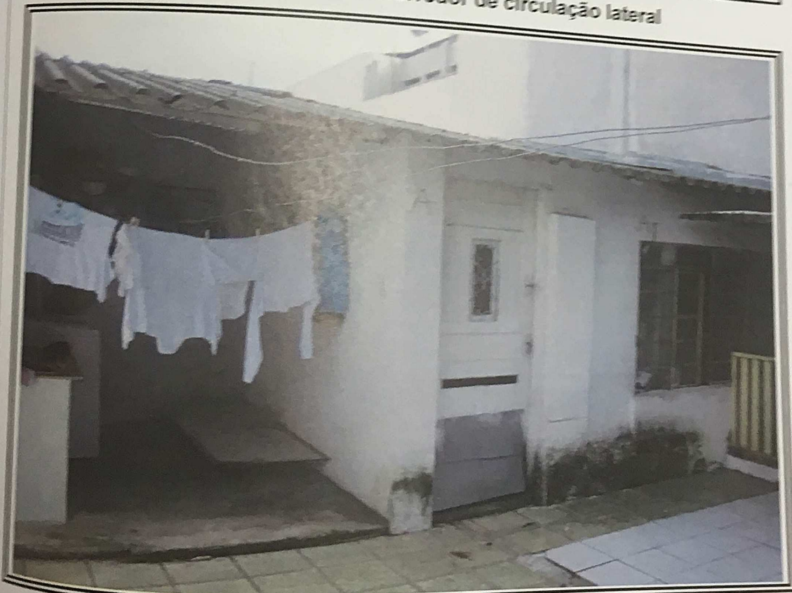
Foto nº 17: Vista da edícula e área de serviço nos fundos do imóvel
