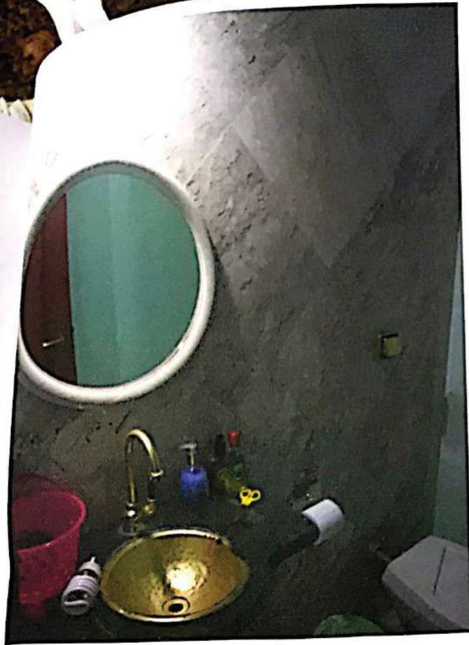
Banheiro com acabamento bom ;barra impermeável até o teto e piso de ladrinho com cuba metálica e metais sanitários "dourados"em bom estado;
