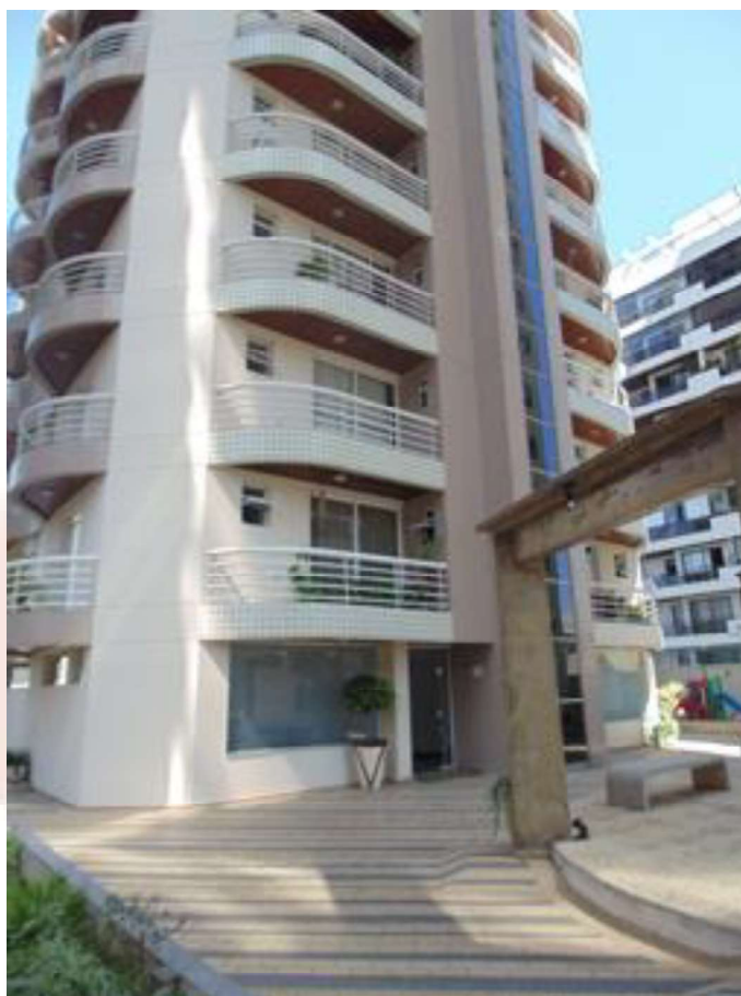
FOTO 03 – Vista Geral do Edifício Platinus
