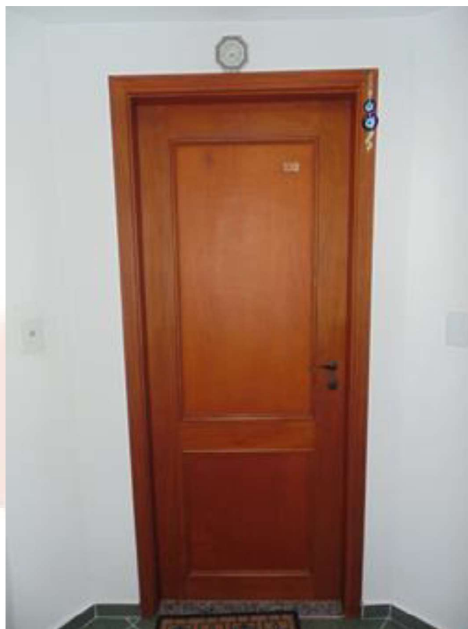
FOTO 05 – Porta de acesso ao apartamento nº 132
