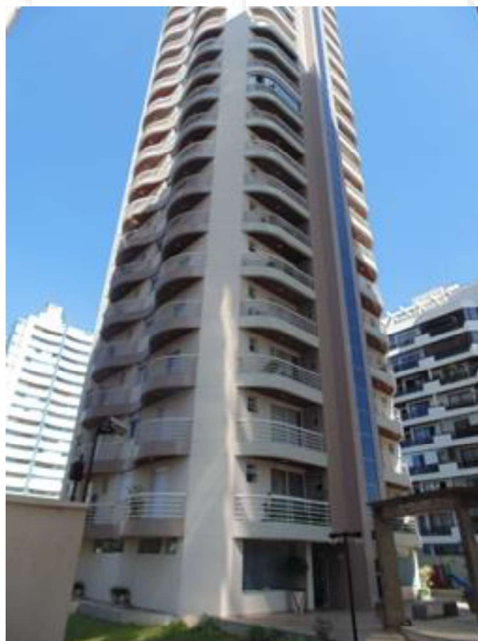
FOTO 02 – Vista Geral do Edifício Platinus
