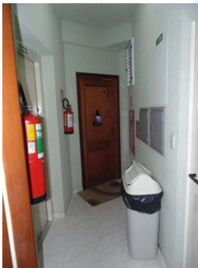
FOTO 17 – Vista interna do Hall de Serviço
