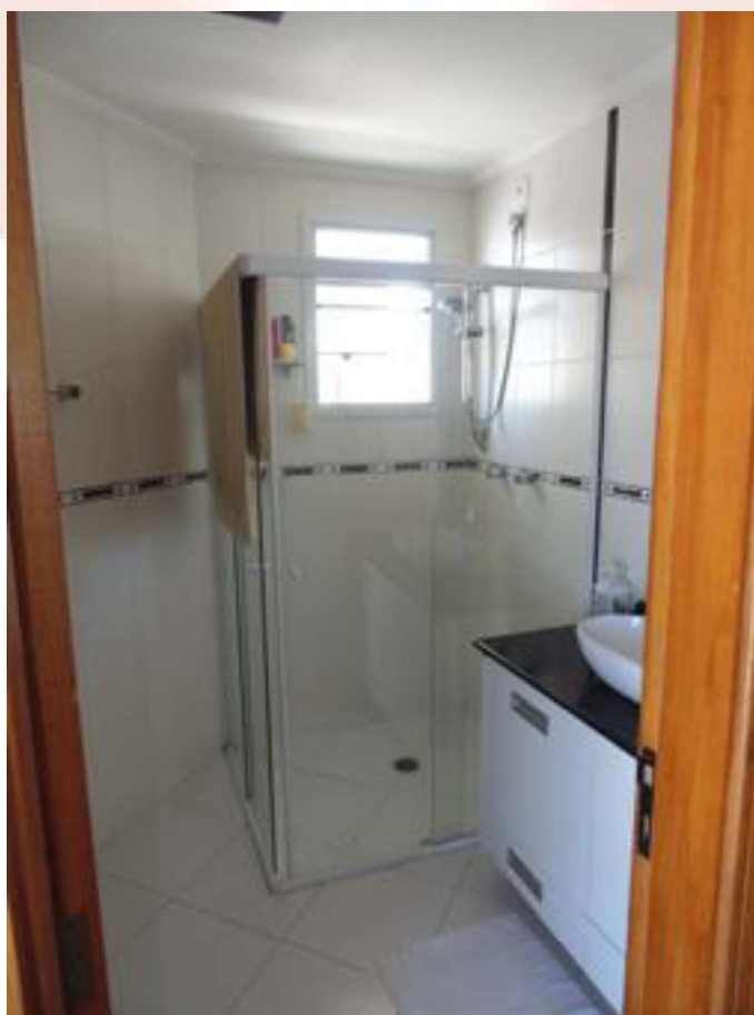
FOTO 23 – Vista interna do Banheiro do Dormitório 1
