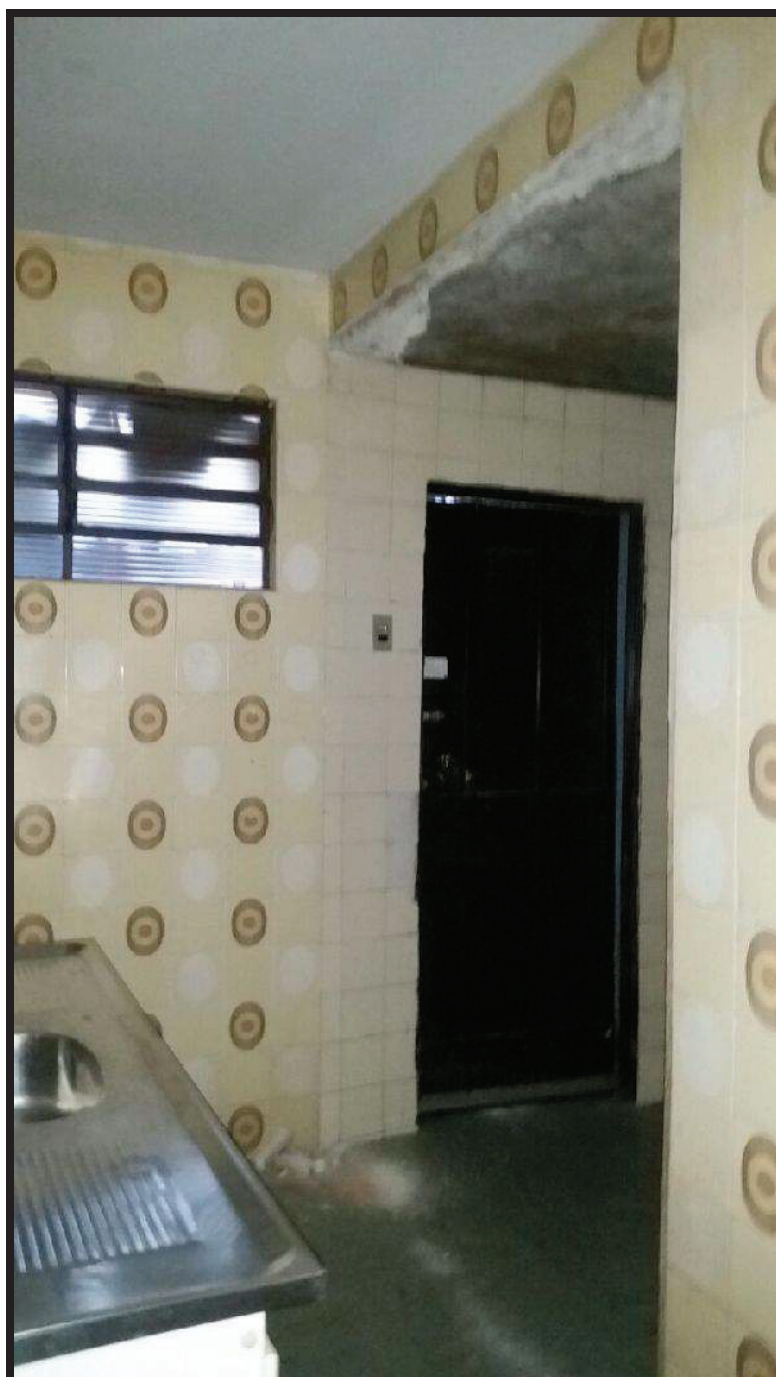
ASPECTOS INTERNOS DO IMÓVEL
