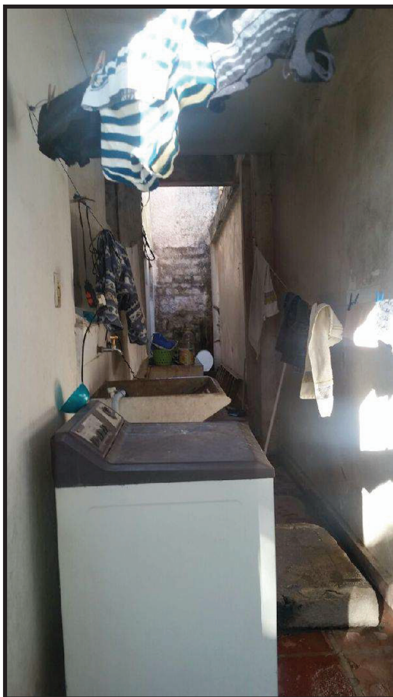
ASPECTOS INTERNOS DO IMÓVEL
